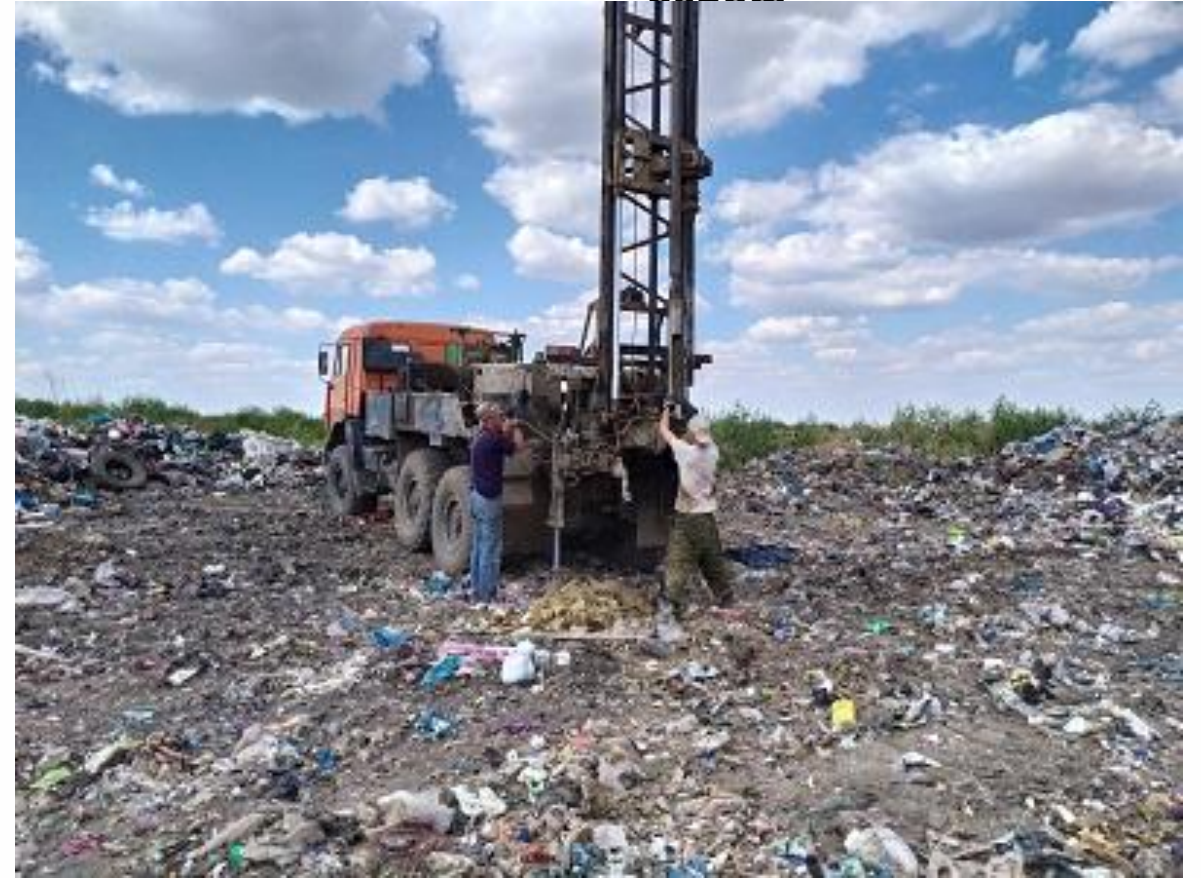
Производство изыскательских работ
