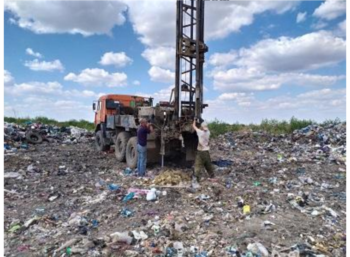
Производство изыскательских работ
