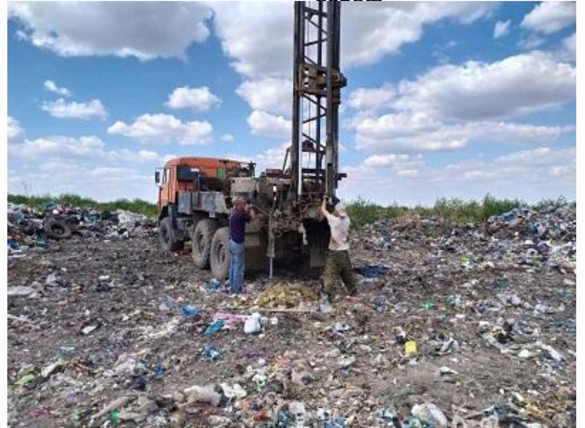
Производство изыскательских работ
