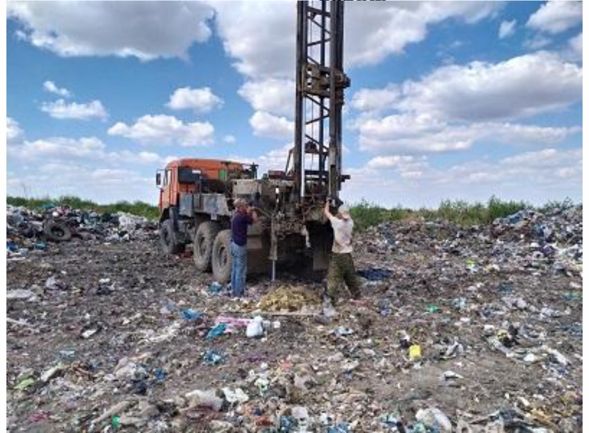
Производство изыскательских работ
