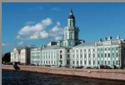
Здание первого музея – Кунсткамеры
