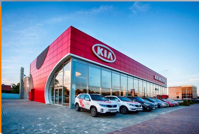
Автоцентр «КИА» Московский проспект, г. Калининград.
