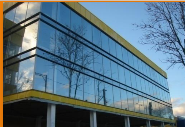
Торгово-выставочный комплекс ул. Суворова 125а , г. Калининград.
