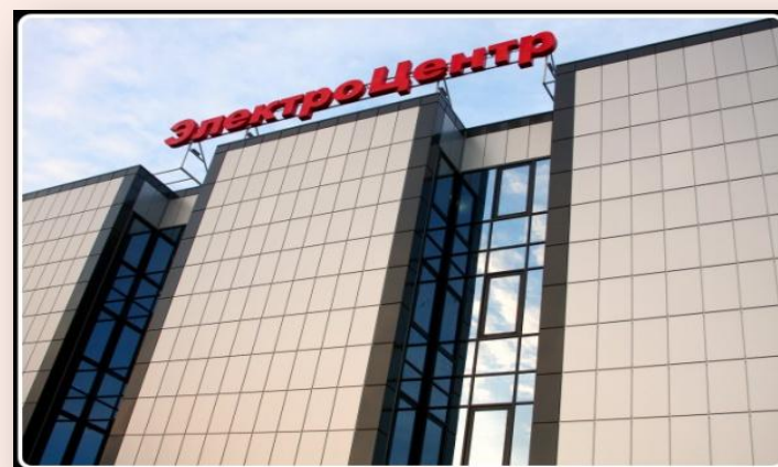
«ЭЛЕКТОРОЦЕНТР» Московский проспект, г. Калининград.
