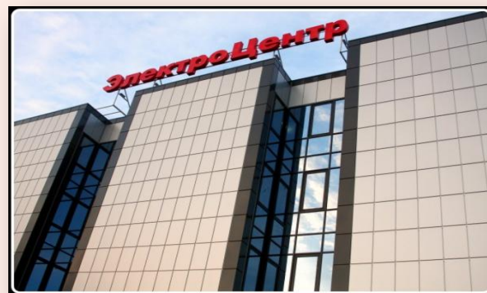
«ЭЛЕКТОРОЦЕНТР» Московский проспект, г. Калининград.
