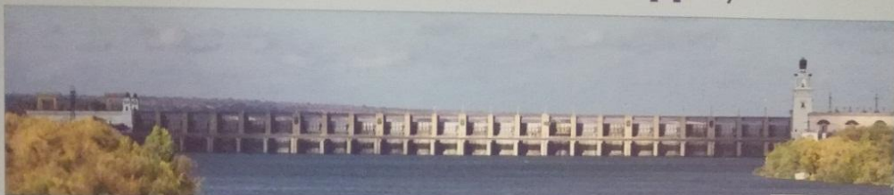
Плотина Цимлянской ГЭС
