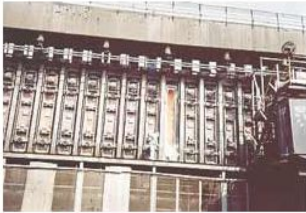
Батарея коксовых печей
