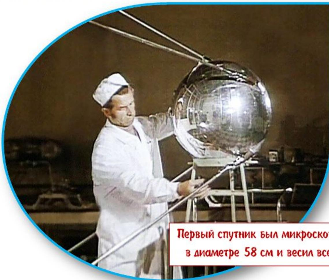
**Первый спутник был микроскопическим, в диаметре 58 см и весил всего 83 кг.**
