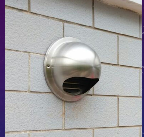
Приемное устройство системы вентиляции
