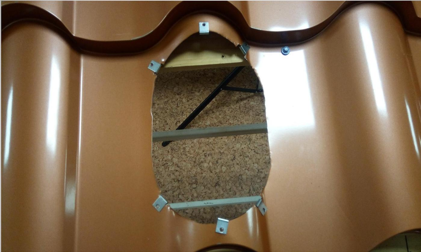
**В намеченных местах, на отверстия устанавливаем усиливающие скобы. Металл можно немного подрезать. Скобы поджать плоскогубцами, чтобы они держались.**
