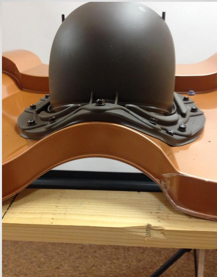
**С достаточным количеством силикона (должен выдавливаться по краям после установки), получаем эстетичный и герметичный узел прохода.**
