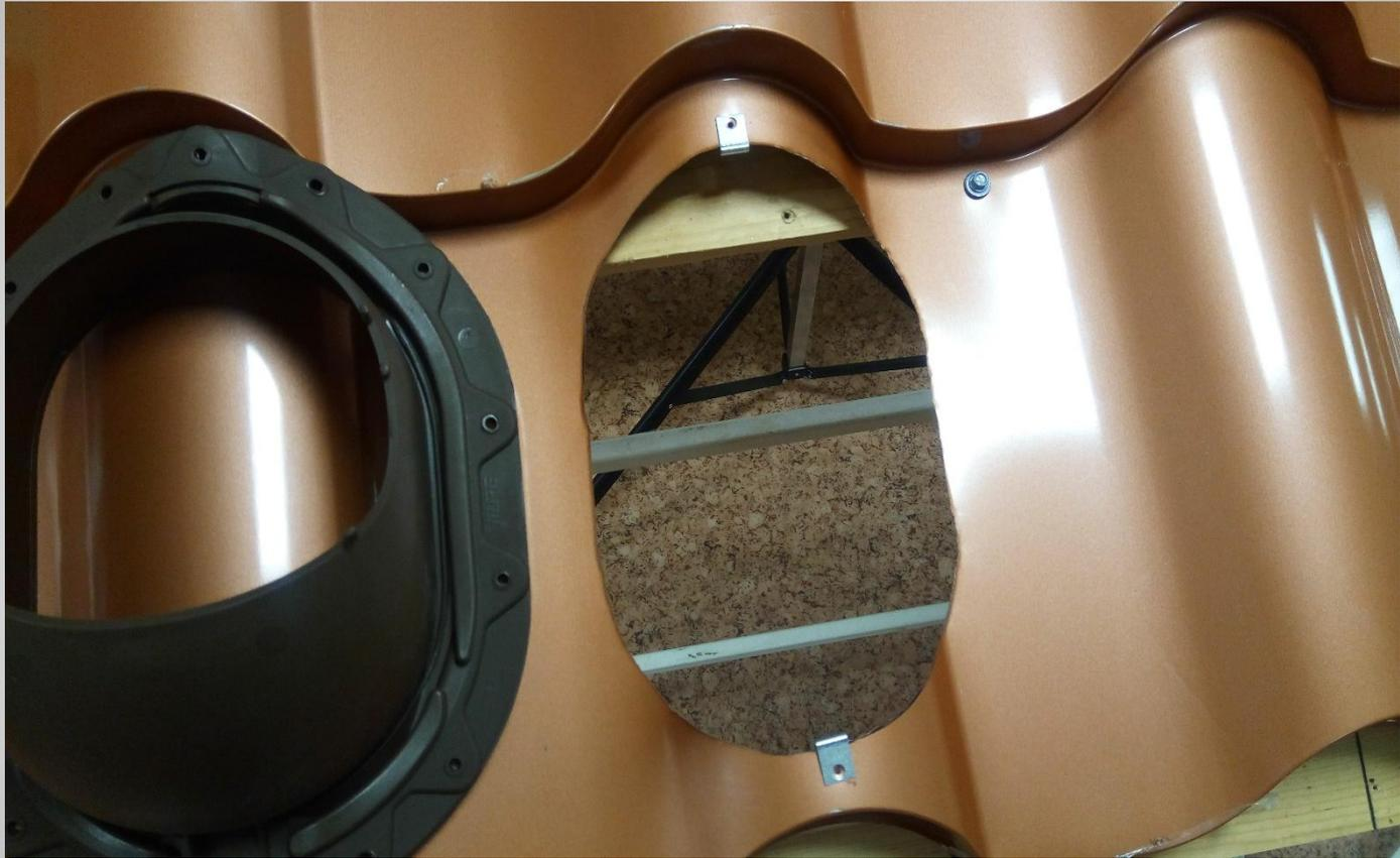
**Сверху и внизу отмечаем отверстия и устанавливаем на них усиливающие скобы.**
