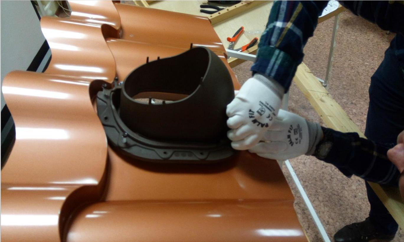
**При установке следить за тем, чтобы саморезы попадали в размеченные отверстия со скобами.**
