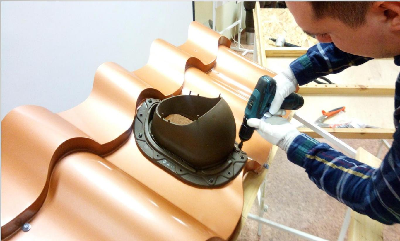
**Наносим силикон и устанавливаем проходной элемент. Аккуратно и неторопясь протягиваем саморезы «от центра – к краям».**
