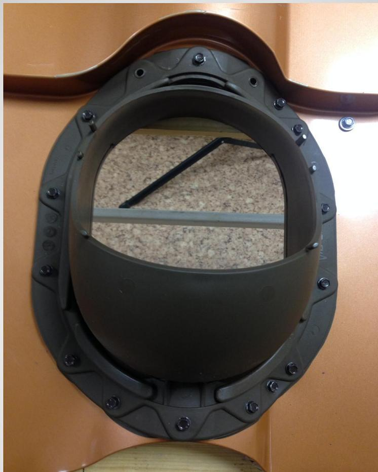
**Лучше использовать два дополнительных острых самореза и закрепить проходку во все штатные отверстия.**
