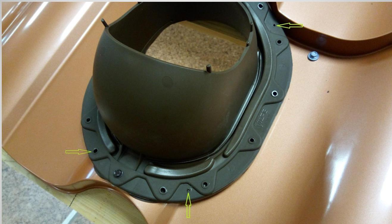
**Тонким сверлом (2-3 мм) сверлим дополнительные отверстия в основании проходного элемента над местом максимального излома профиля МЧ справа. Слева намечаем места креплений в штатные отверстия**
