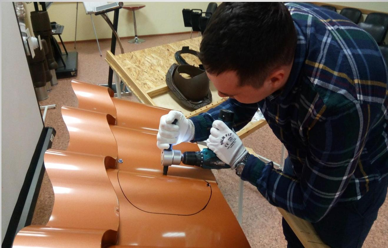
**Вырезать отверстие в металлочерепице «сверчком», или ножницами (применение «болгарки» запрещается)**
