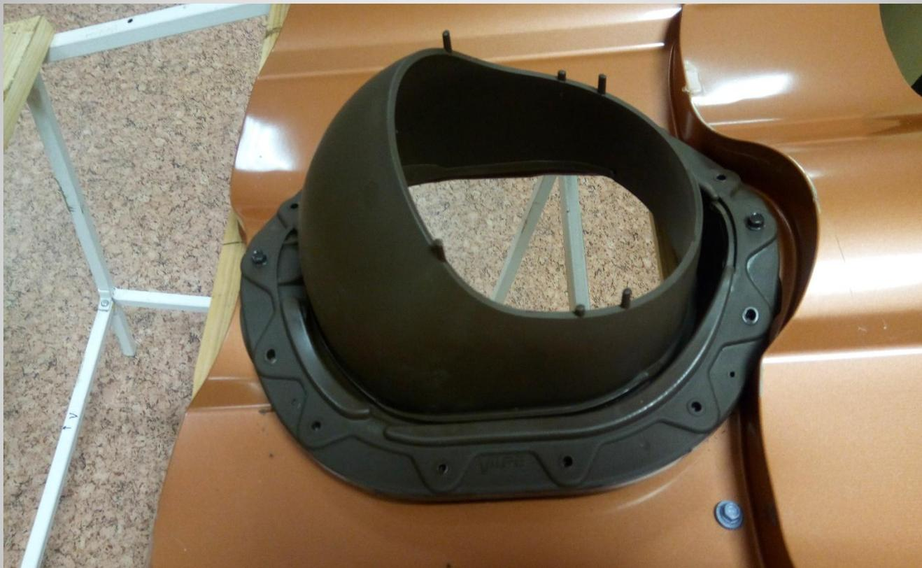
**Плотно, без силикона, устанавливаем Muotokate – проходной элемент на два самореза. Верхний и нижний.**
