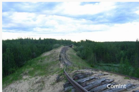
Строительство железных дорог
