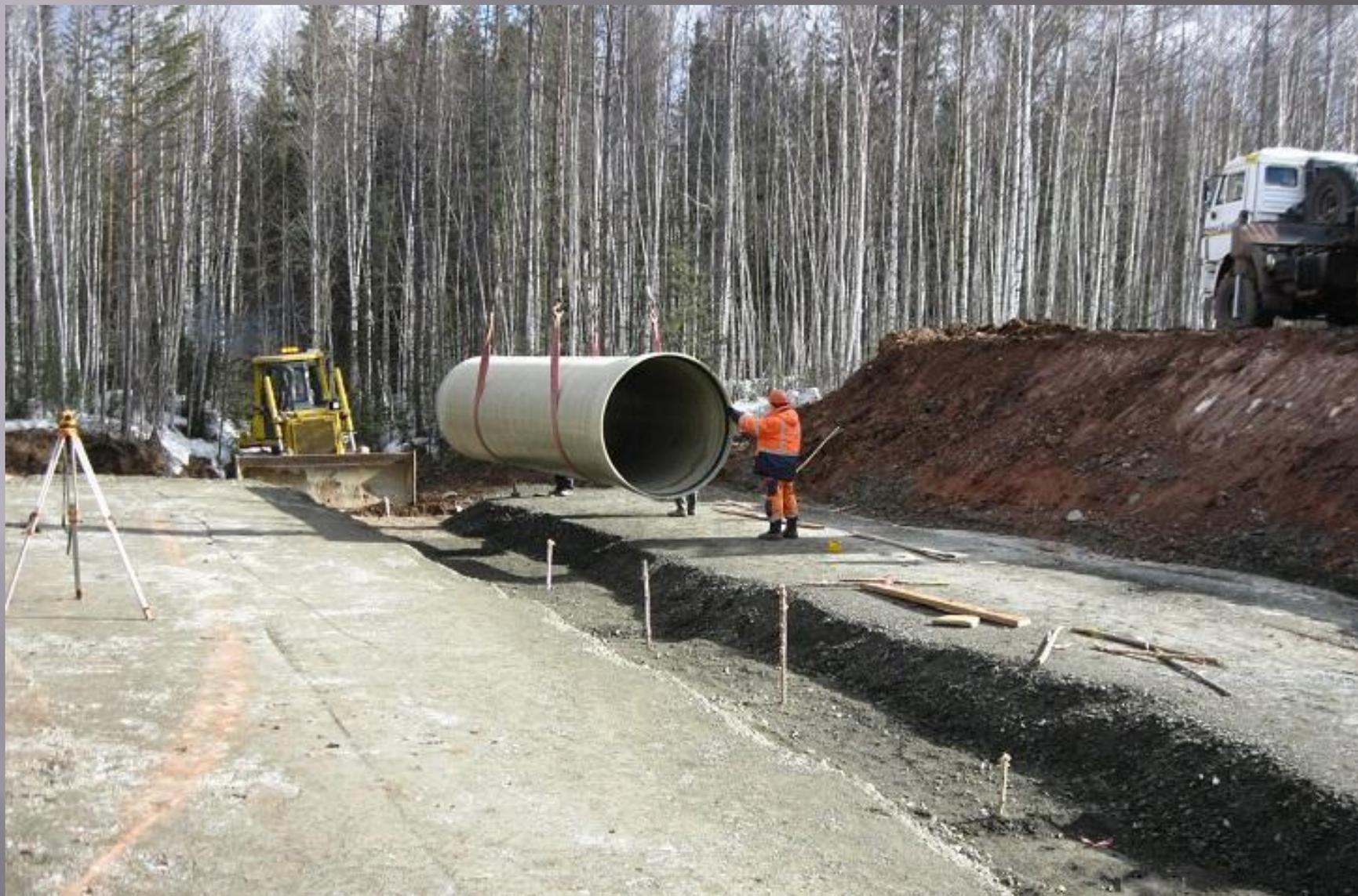
Рис. 2 – Водопропускная труба
