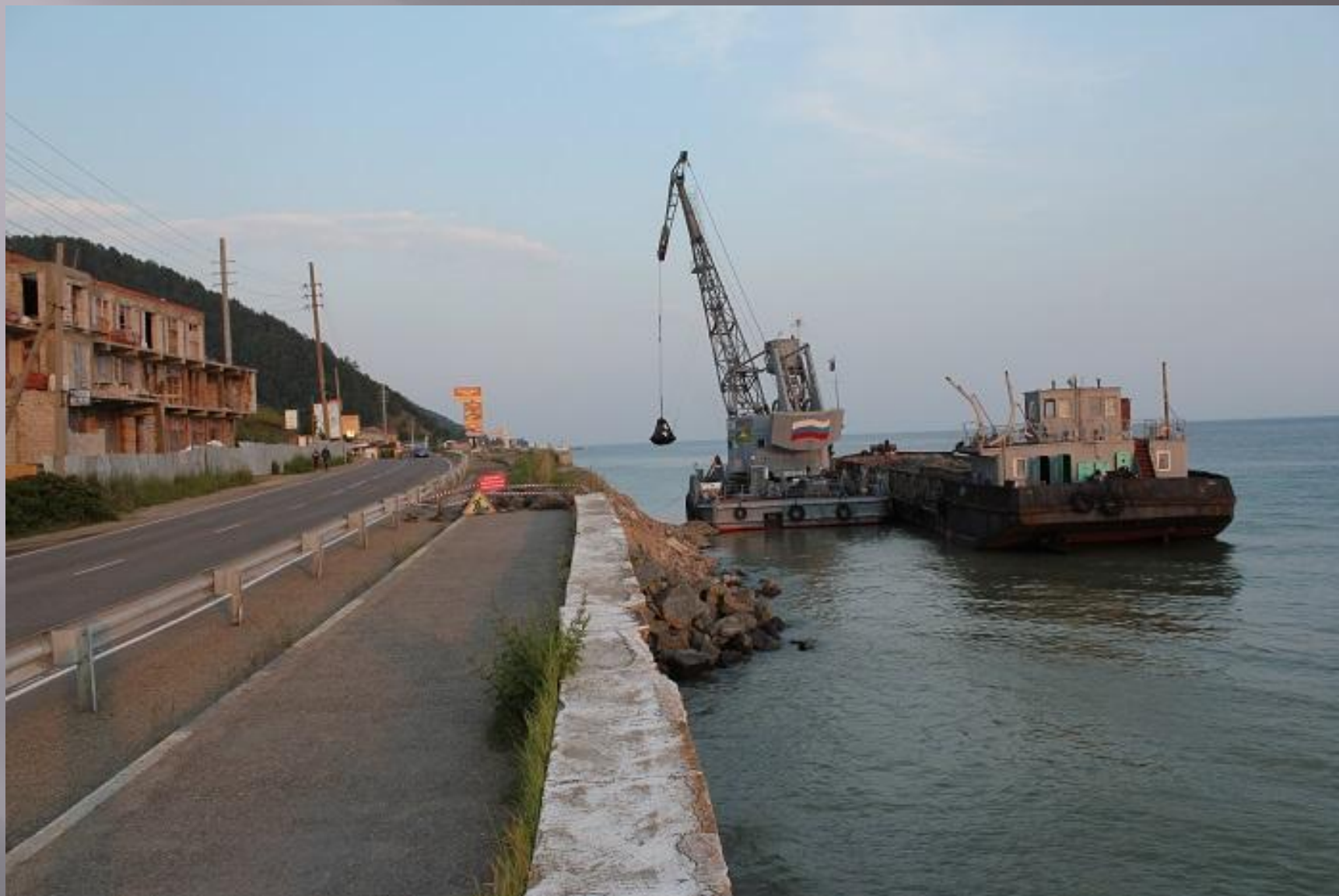
Рис. 6 – Подпорная стенка (Листвянка)
