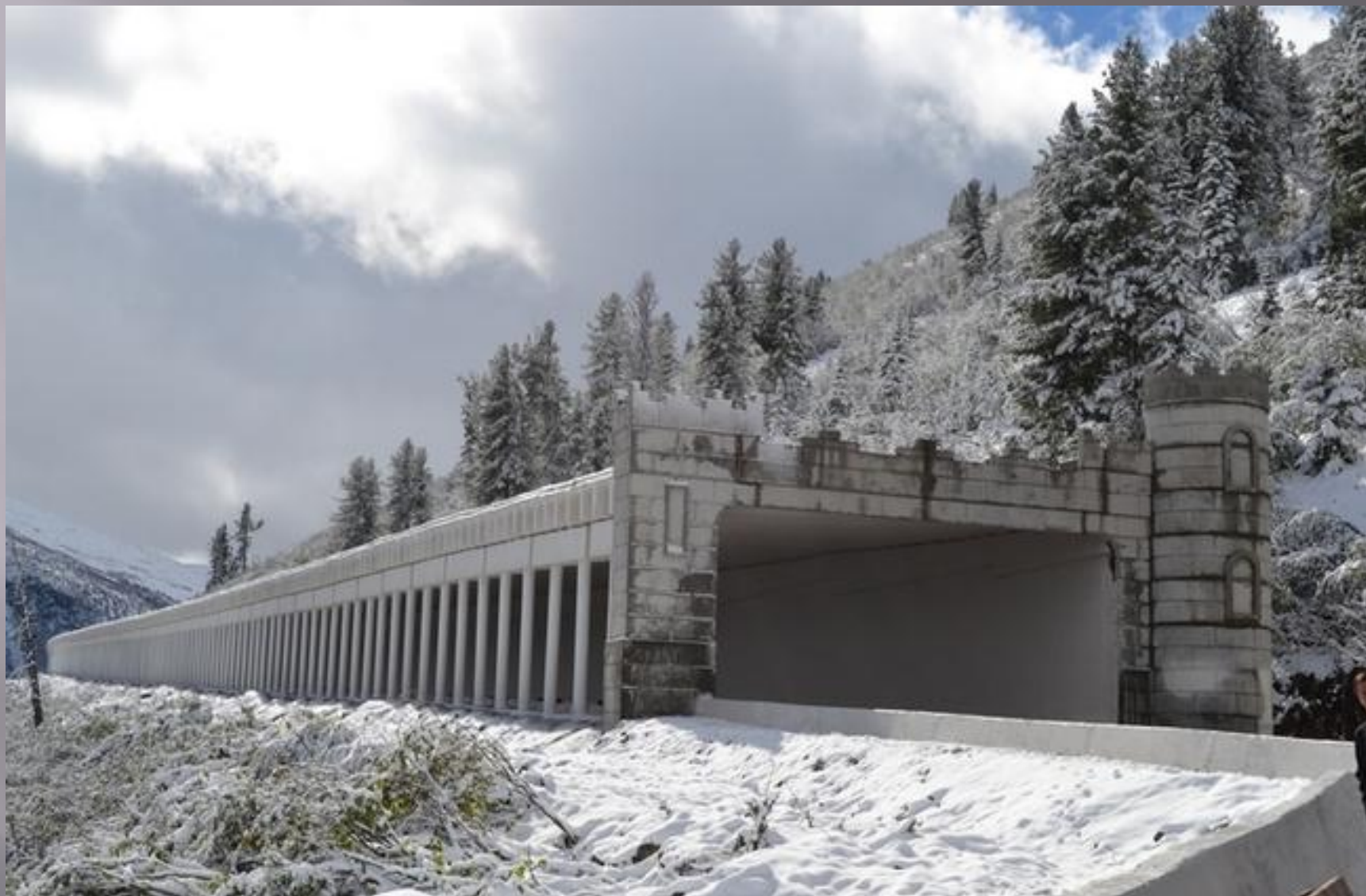
Рис. 5 – Защитная галерея (Красноярский край)
