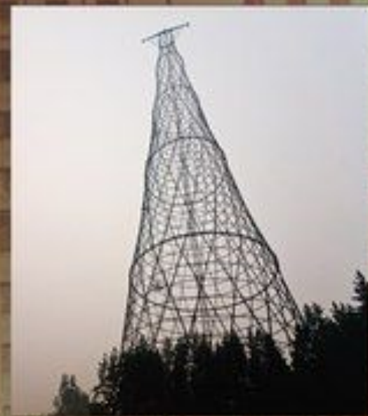
Шуховская башня В. Шухов 1920-1922
