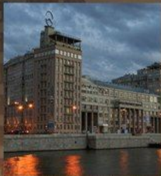
Дом на Набережной (Дом правительства) 1931
