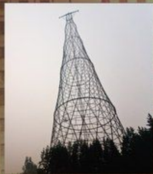
Шуховская башня В. Шухов 1920-1922
