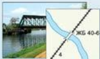
Железная дорога и железобетонный мост
