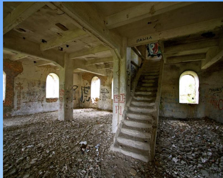
Сохранившийся цех мельницы.
