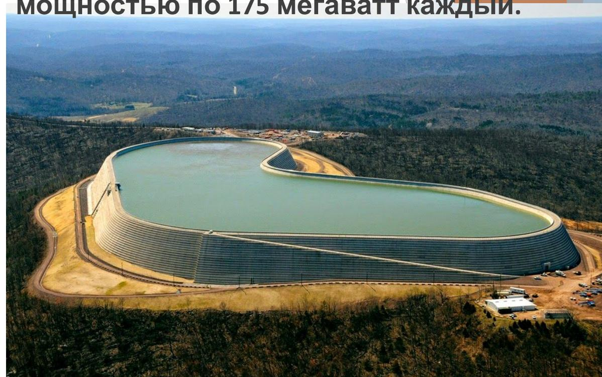
**Со временем, в 1999 году, мощность обоих генераторов была увеличена до 225 мегаватт. Размеры верхнего резервуара впечатляют. Высота стены - 30 метров. Объем - 5,7 млн метров кубических.**
