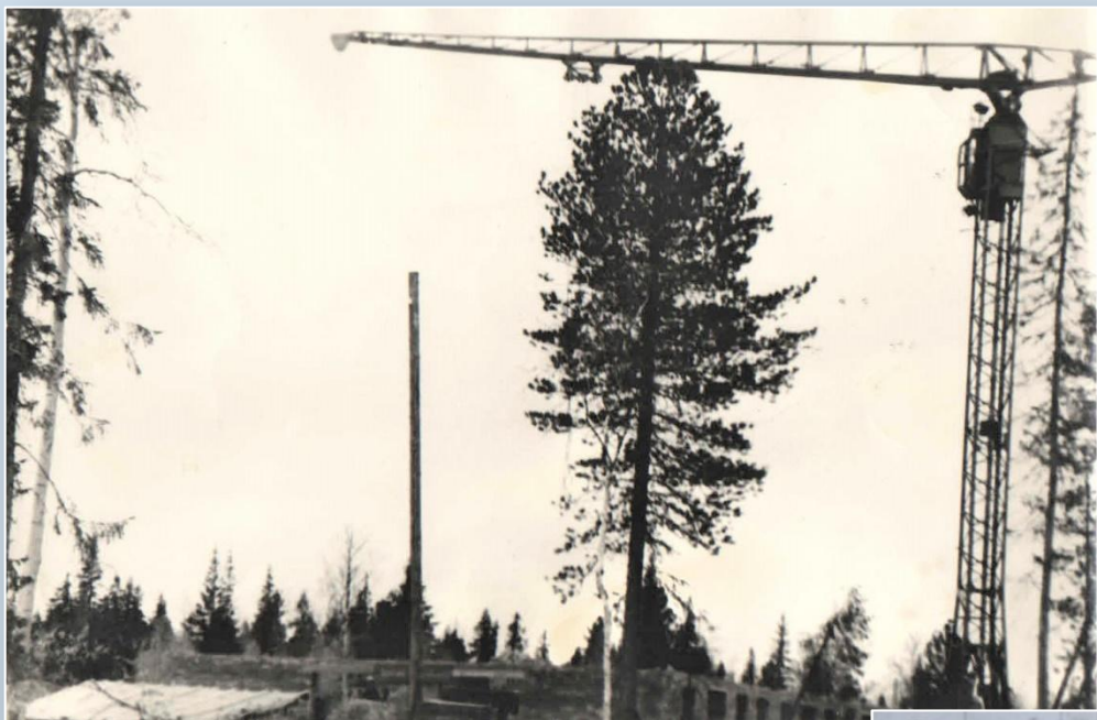
Строительство первого жилого дома кв. Южный, 1974 г.
