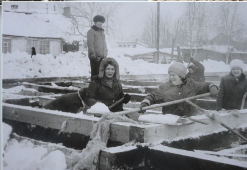
Строительство жилого дома АТП
