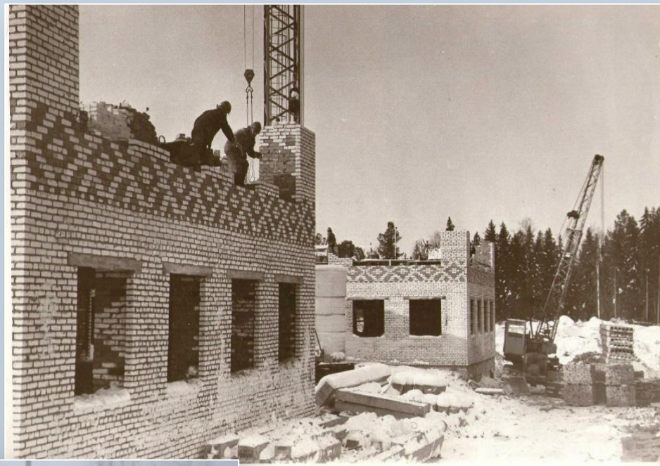
Строительство детского комбината «Сказка» кв. Южный, 1980 г.
