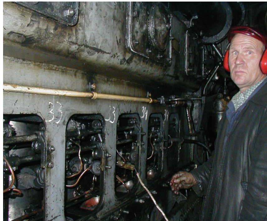
б) в дизельном помещении тепловоза
