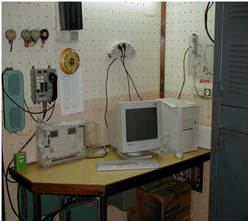
а) в производственном помещении станции РИ
