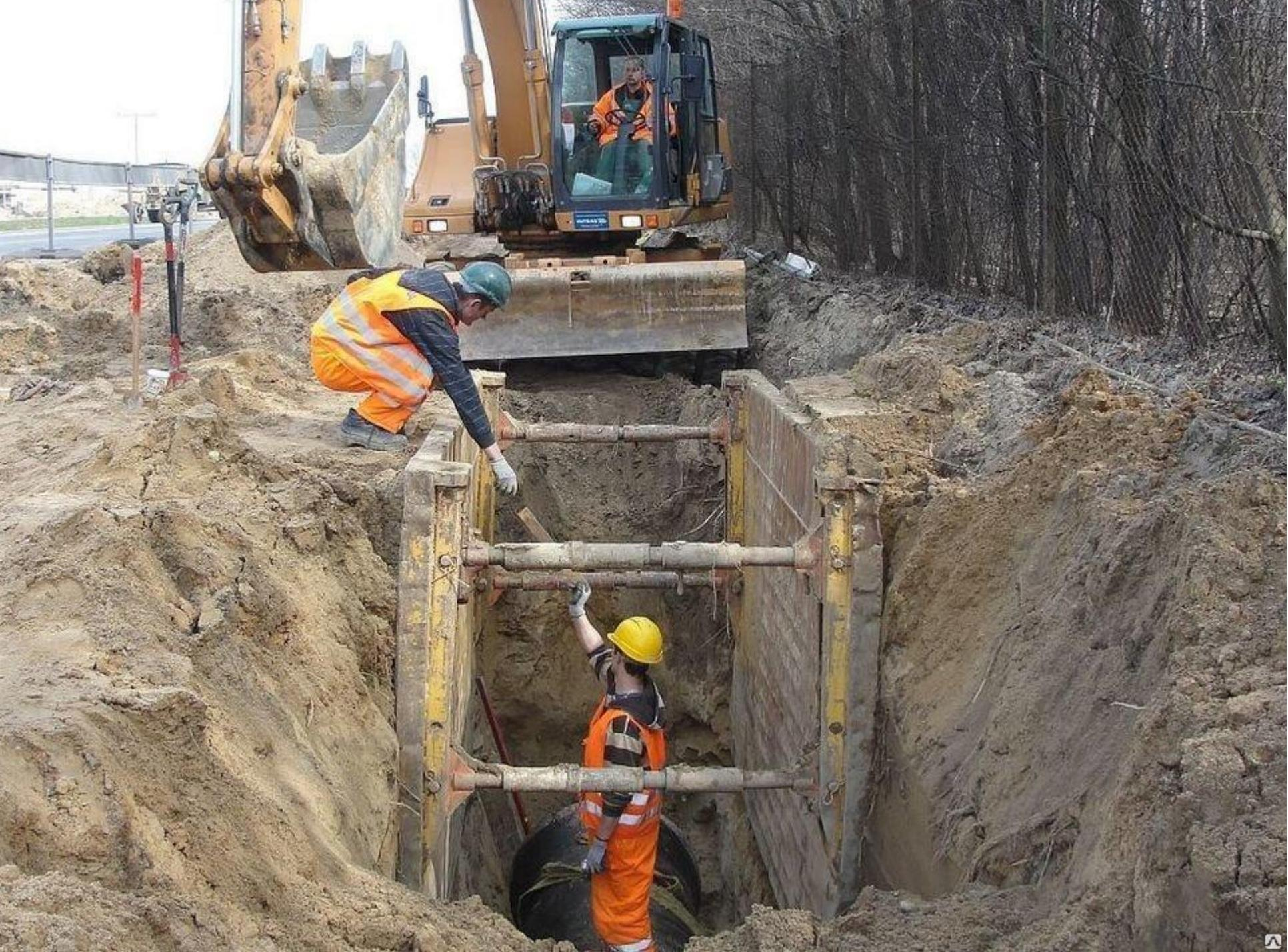
При производстве работ нахождение работников в выемках с вертикальными стенками без крепления в песчаных, пылевато-глинистых и талых грунтах допускается при расположении этих выемок выше уровня грунтовых вод, при отсутствии вблизи них подземных сооружений, а также на глубине не более:
