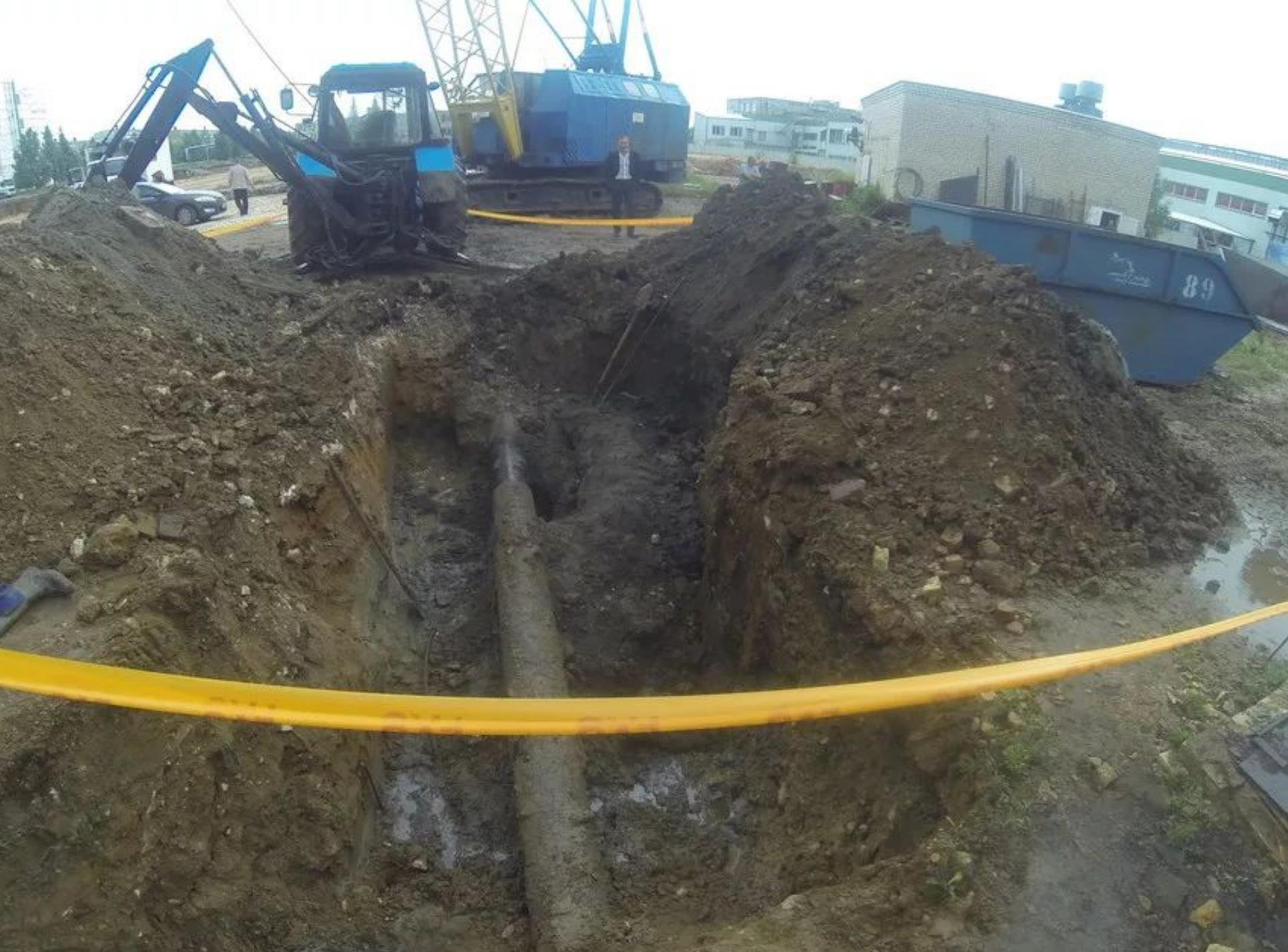
**Производство земляных работ в охранной зоне** кабелей высокого напряжения, действующего газопровода, других коммуникаций, а также на участках с возможным патогенным заражением почвы (свалки, скотомогильники, кладбища и тому подобное) необходимо осуществлять по наряду-допуску.
