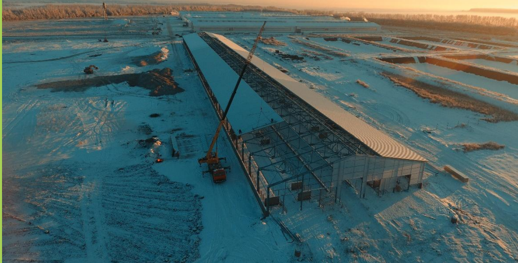
Строительство МТФ Малмыжка-2 очередь
