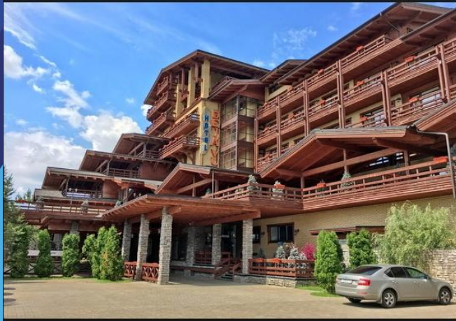
Горнолыжный комплекс «Свияга», г. Казань
