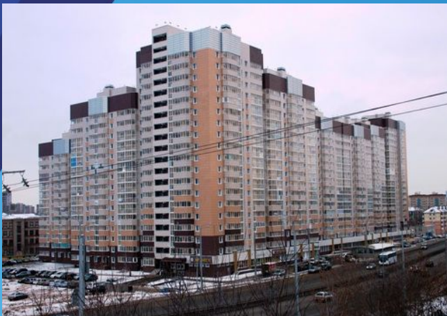
ЖК «Подаметьевская», г. Казань
