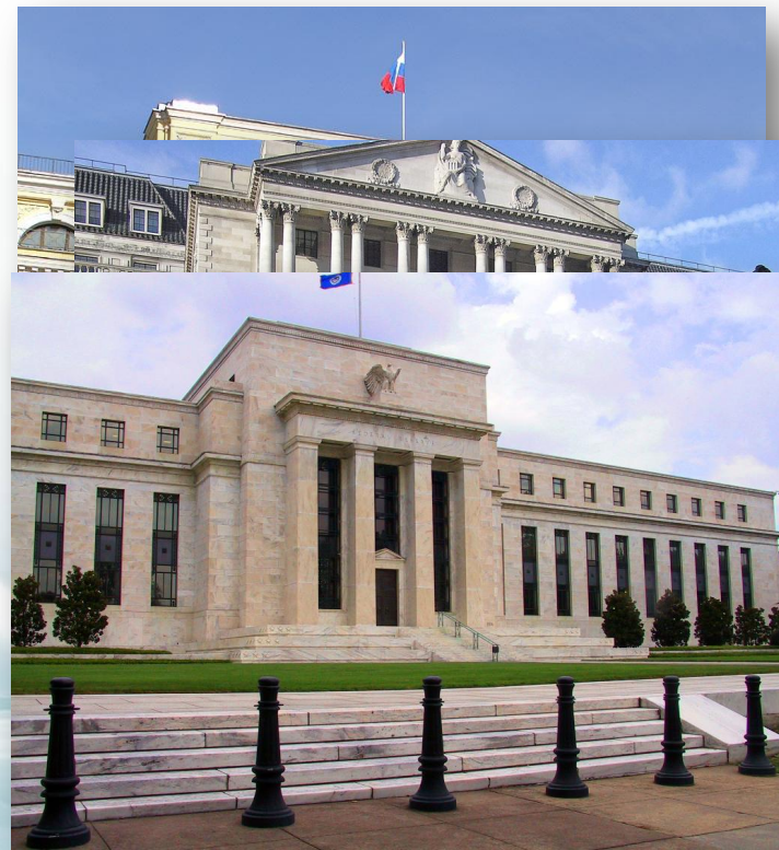
Федеральная резервная система США
