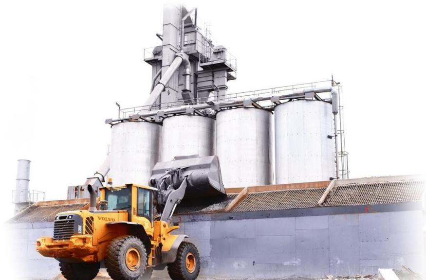
Заводы имеют мощный пылеуловительный блок, включающий фильтр, вытяжной вентилятор, транспортеры минерального материала и рубу.
