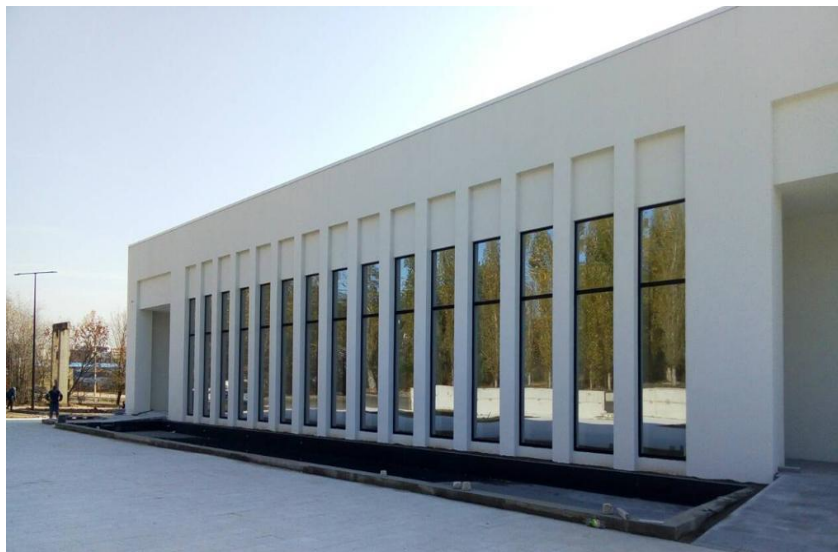
г. Воронеж завершается строительство Срок сдачи 2020г.
