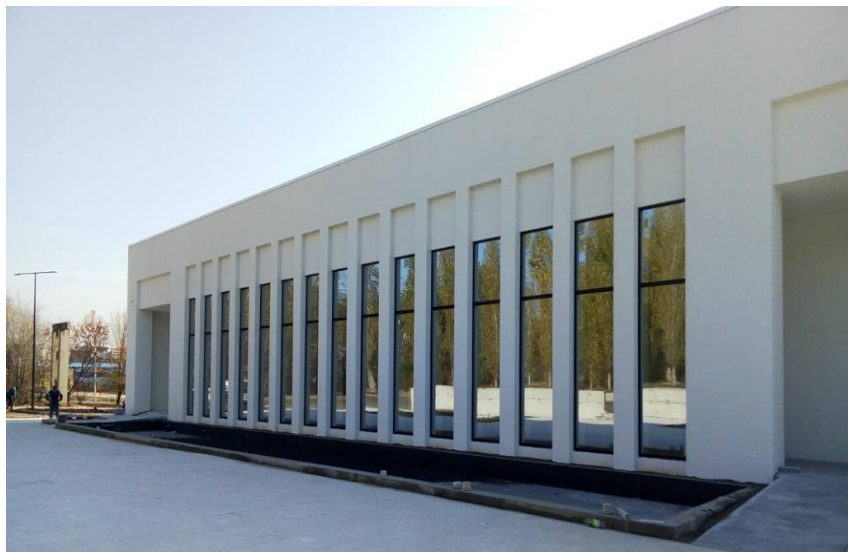
г. Воронеж завершается строительство Срок сдачи 2020г.
