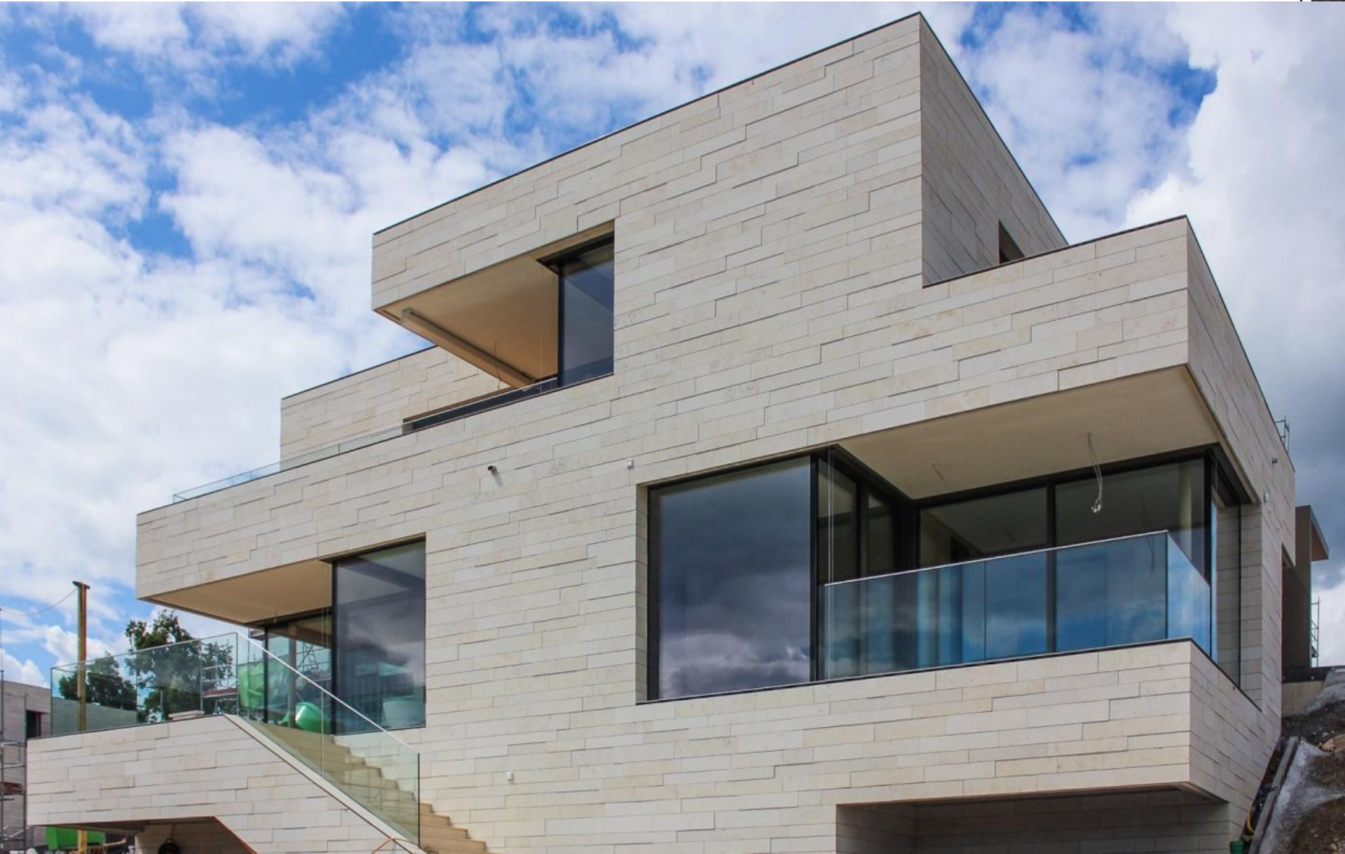
Рис.2. Отделка вентилируемых фасадов известняком
