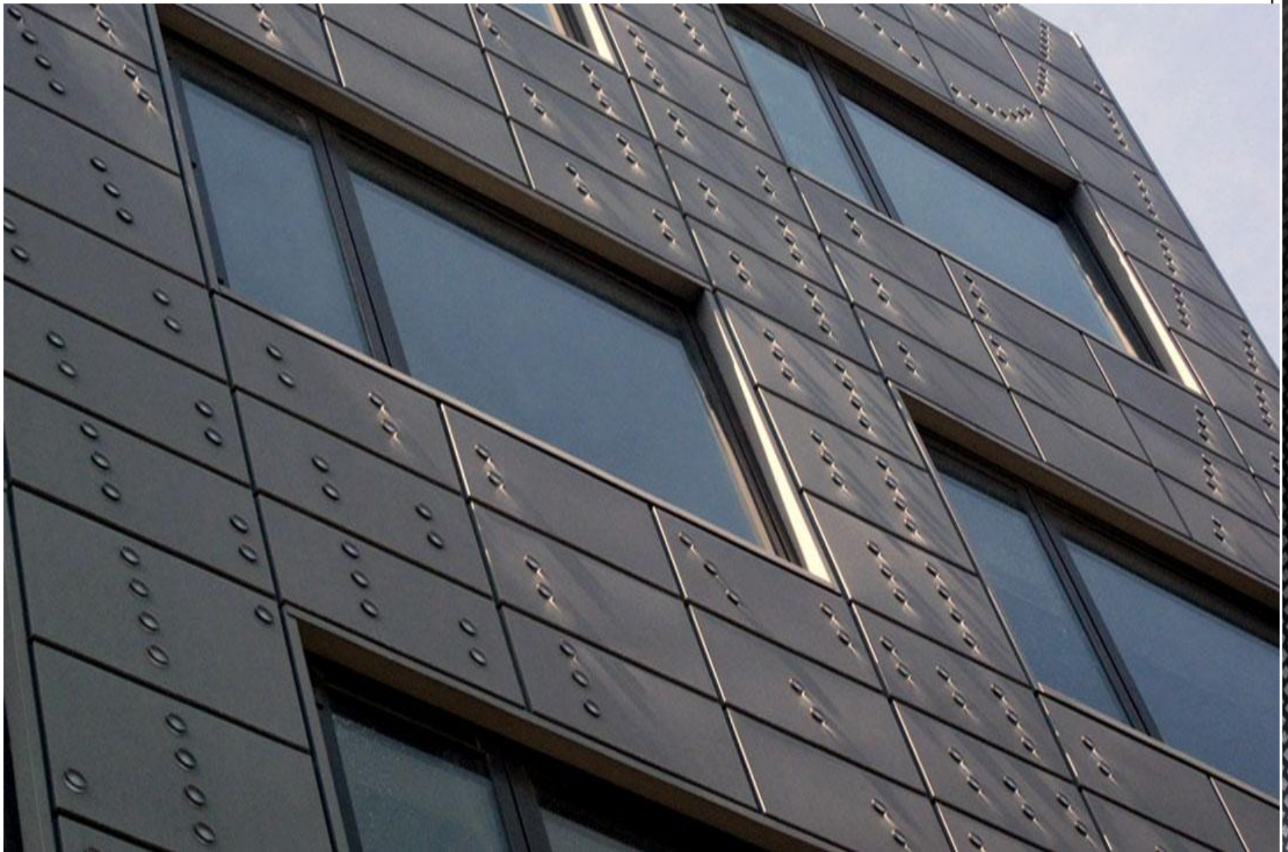
Рис.. Вентилируемый фасад из оцинкованных металлокассет.
