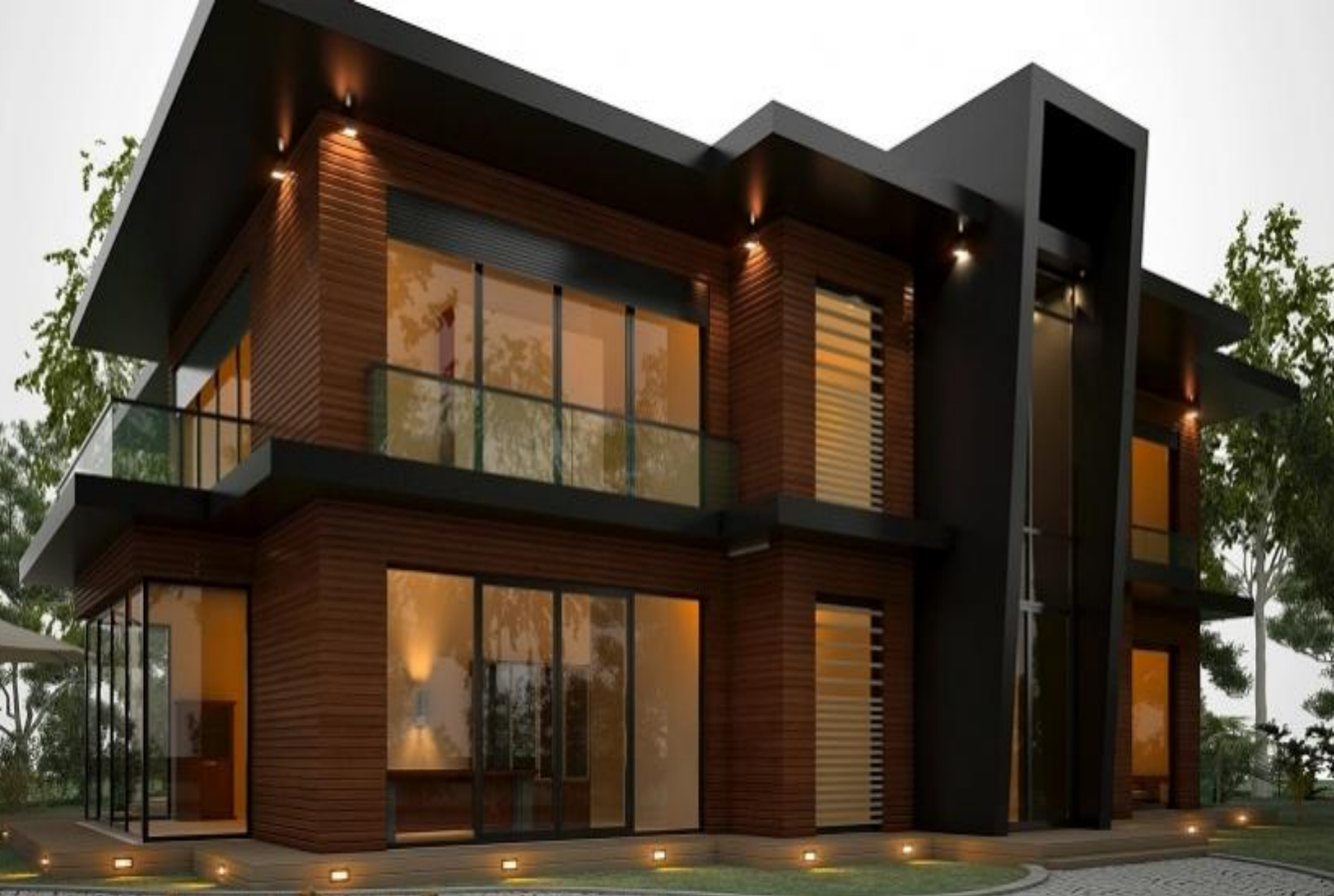
Рис.2. Вентилируемый фасад из доски лиственницы
