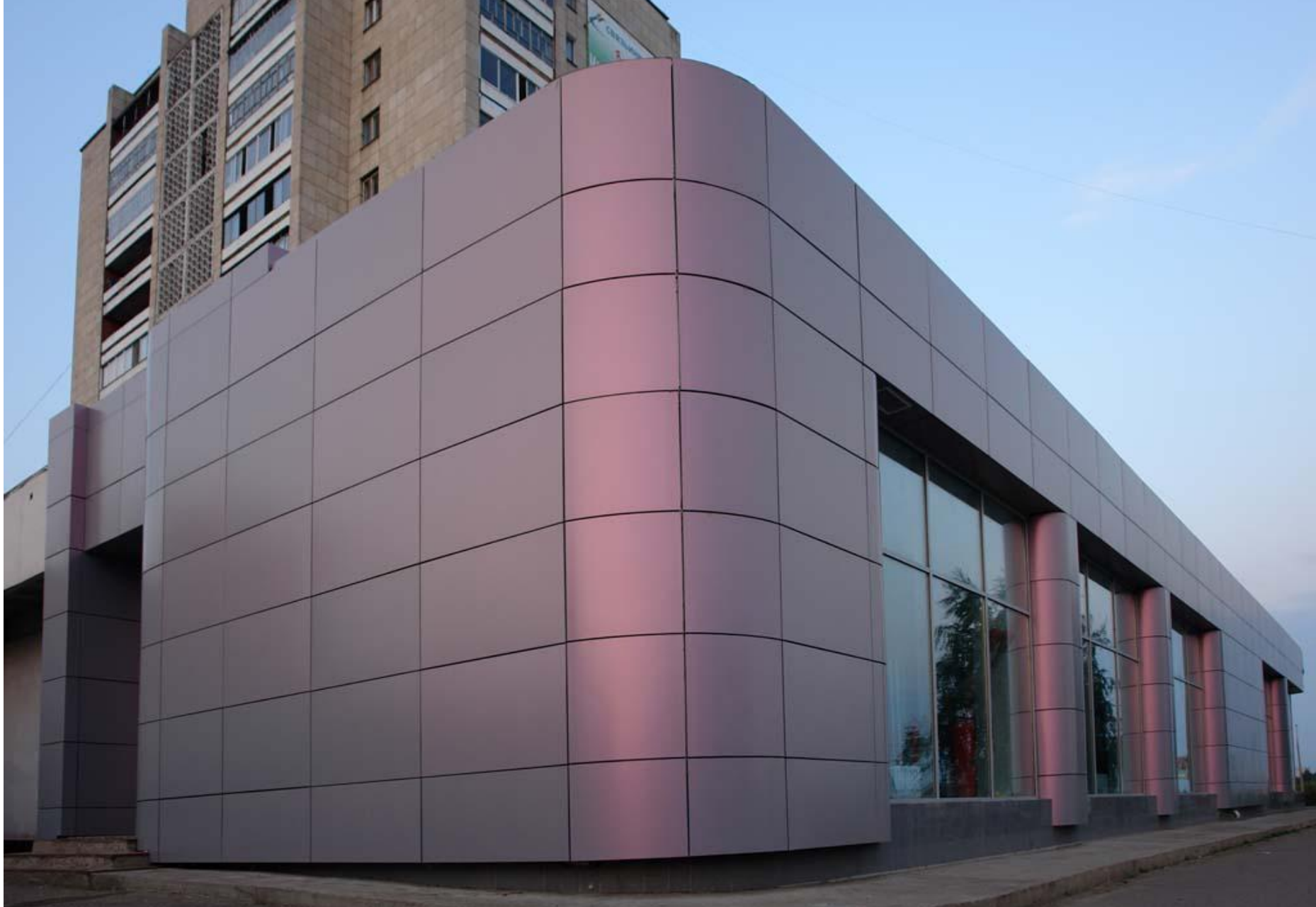
Рис. Облицовка фасадов алюминиевыми композитными материалами.
