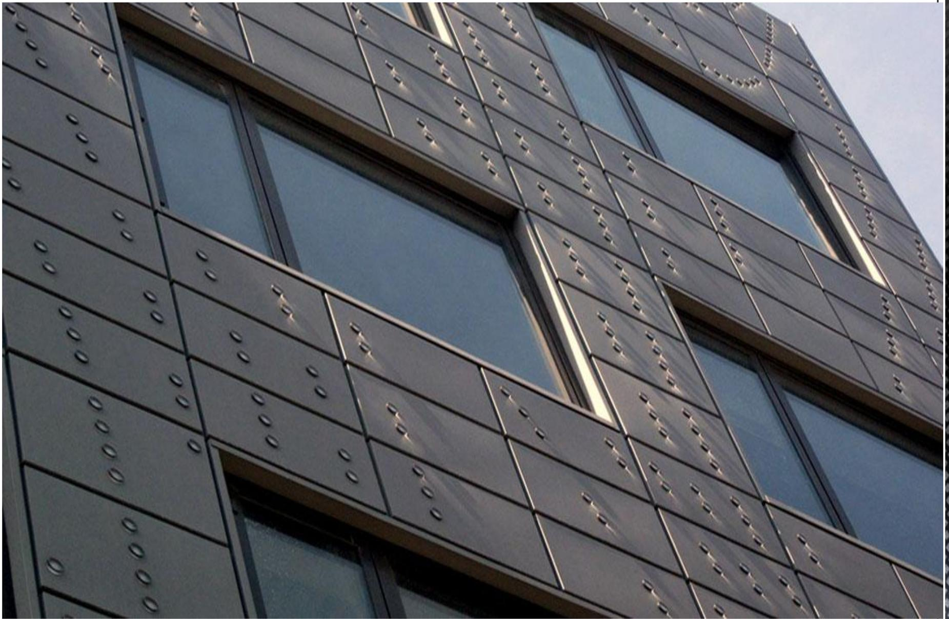
*Рис.. Вентилируемый фасад из оцинкованных металлокассет.*
