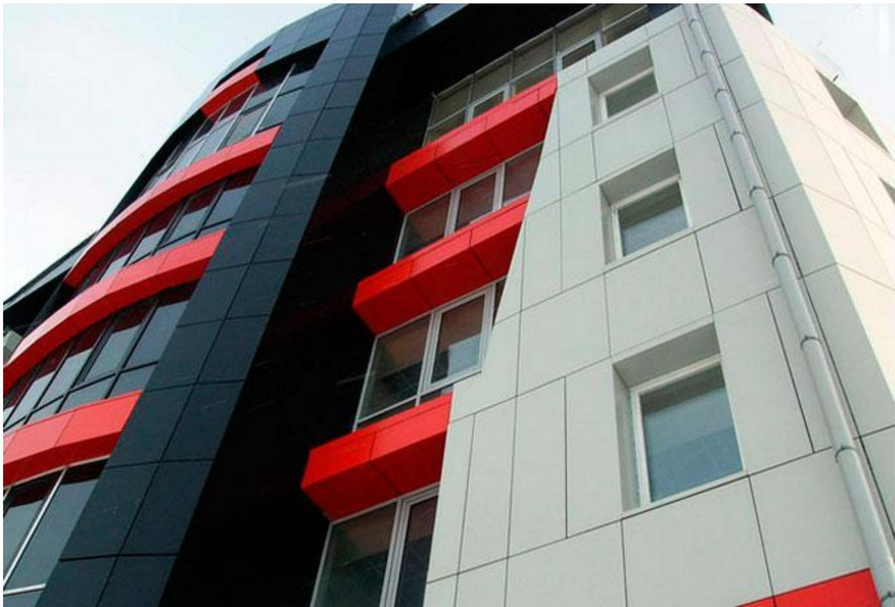
*Рис. Вентилируемый фасад с композитными панелями*
