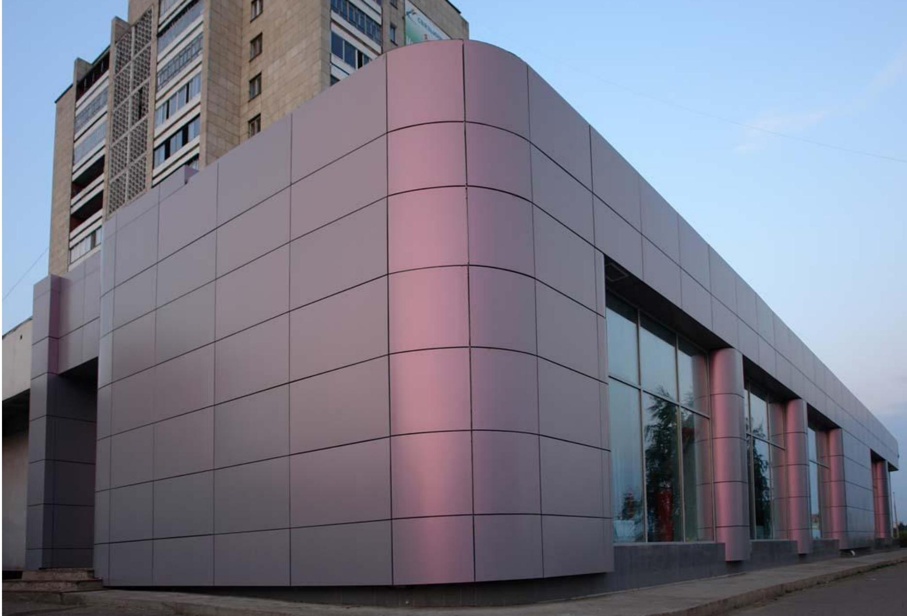
*Рис. Облицовка фасадов алюминиевыми композитными материалами.*
