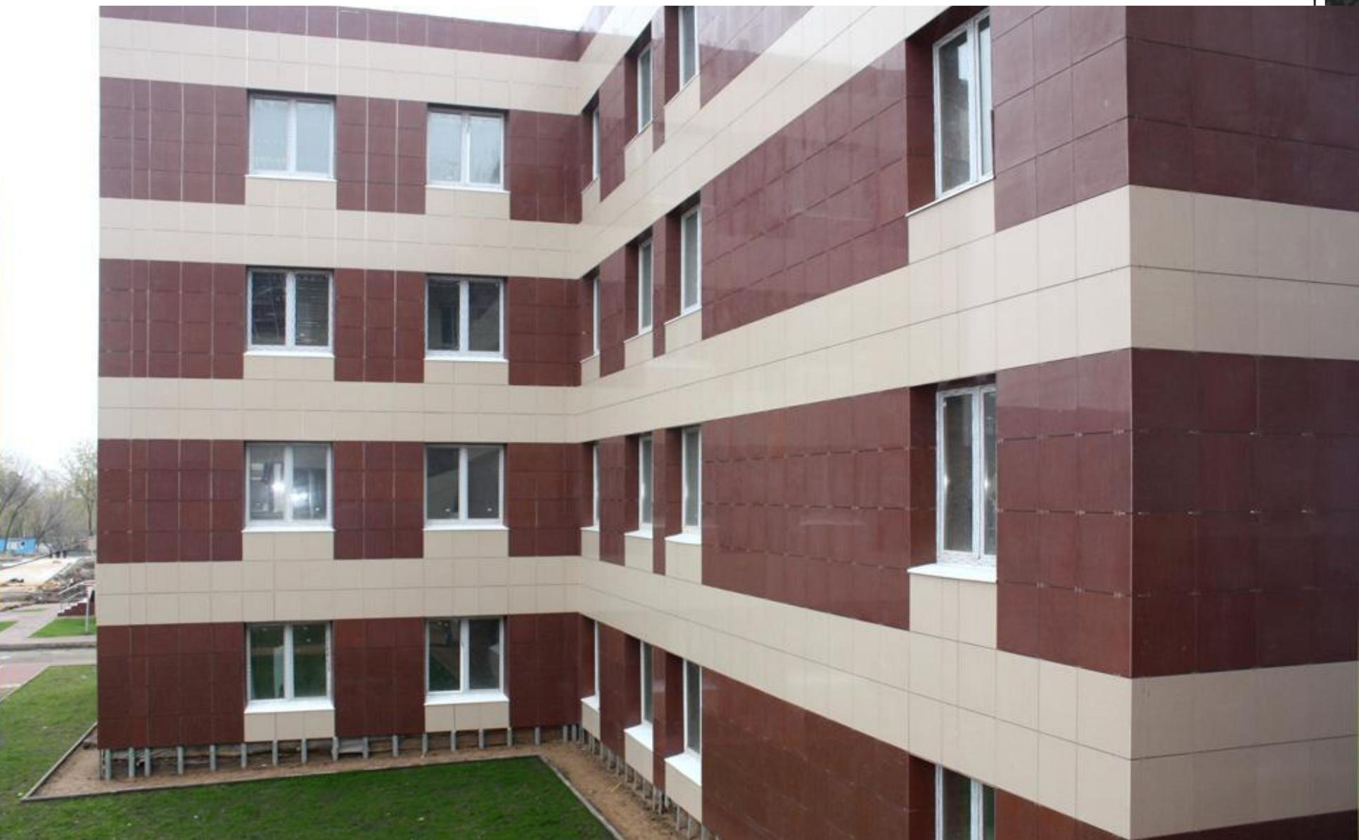
*Рис. Вентилируемый фасад из керамогранита*
