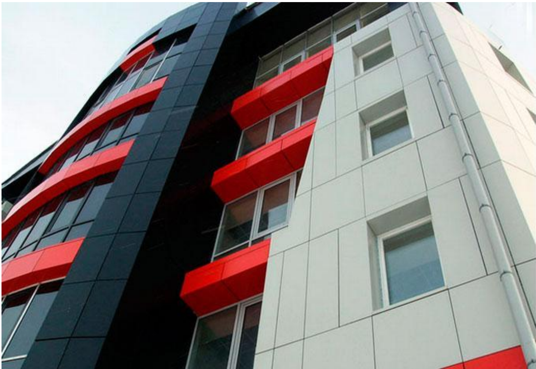
Рис. Вентилируемый фасад с композитными панелями
