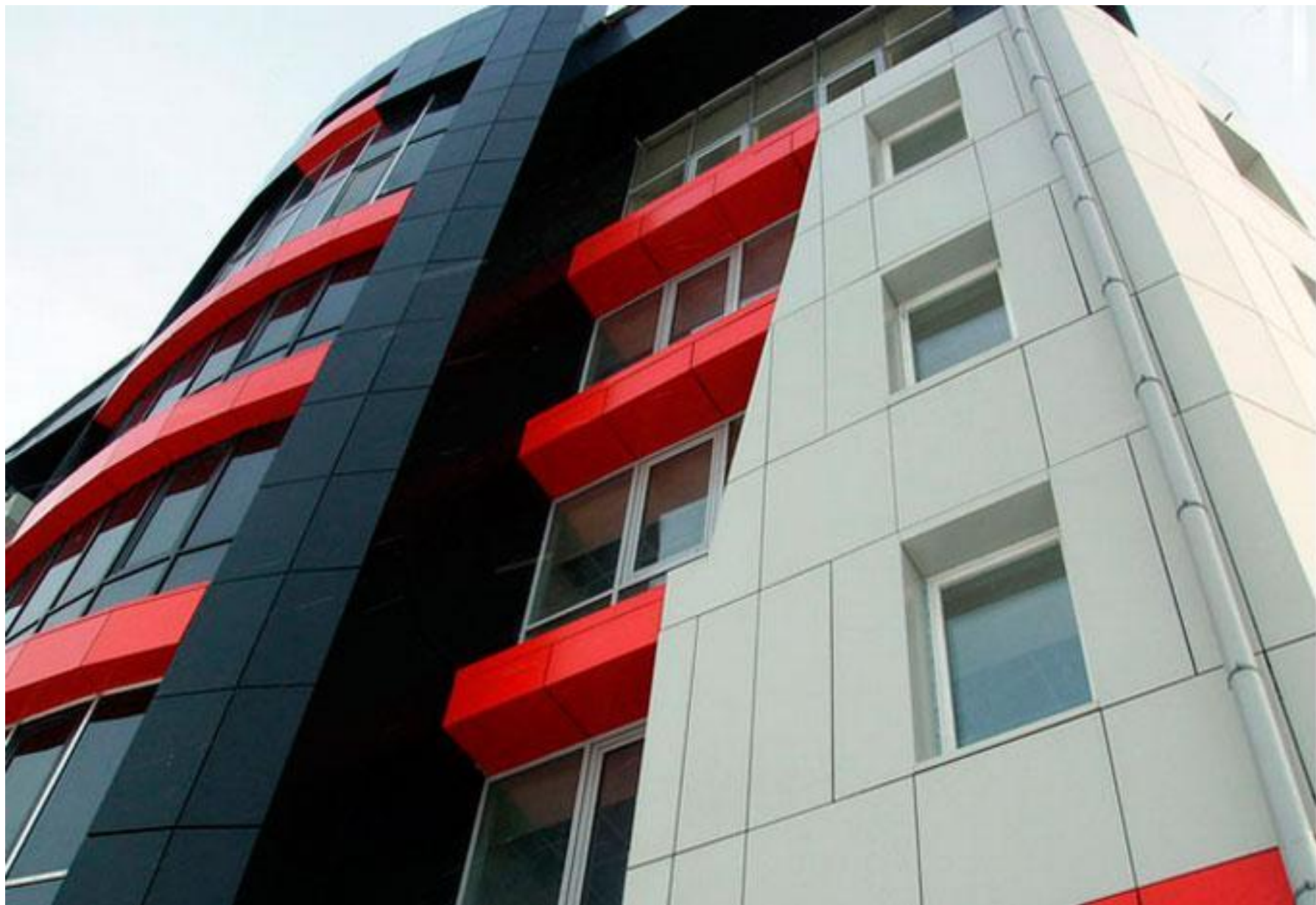
Рис. Вентилируемый фасад с композитными панелями
