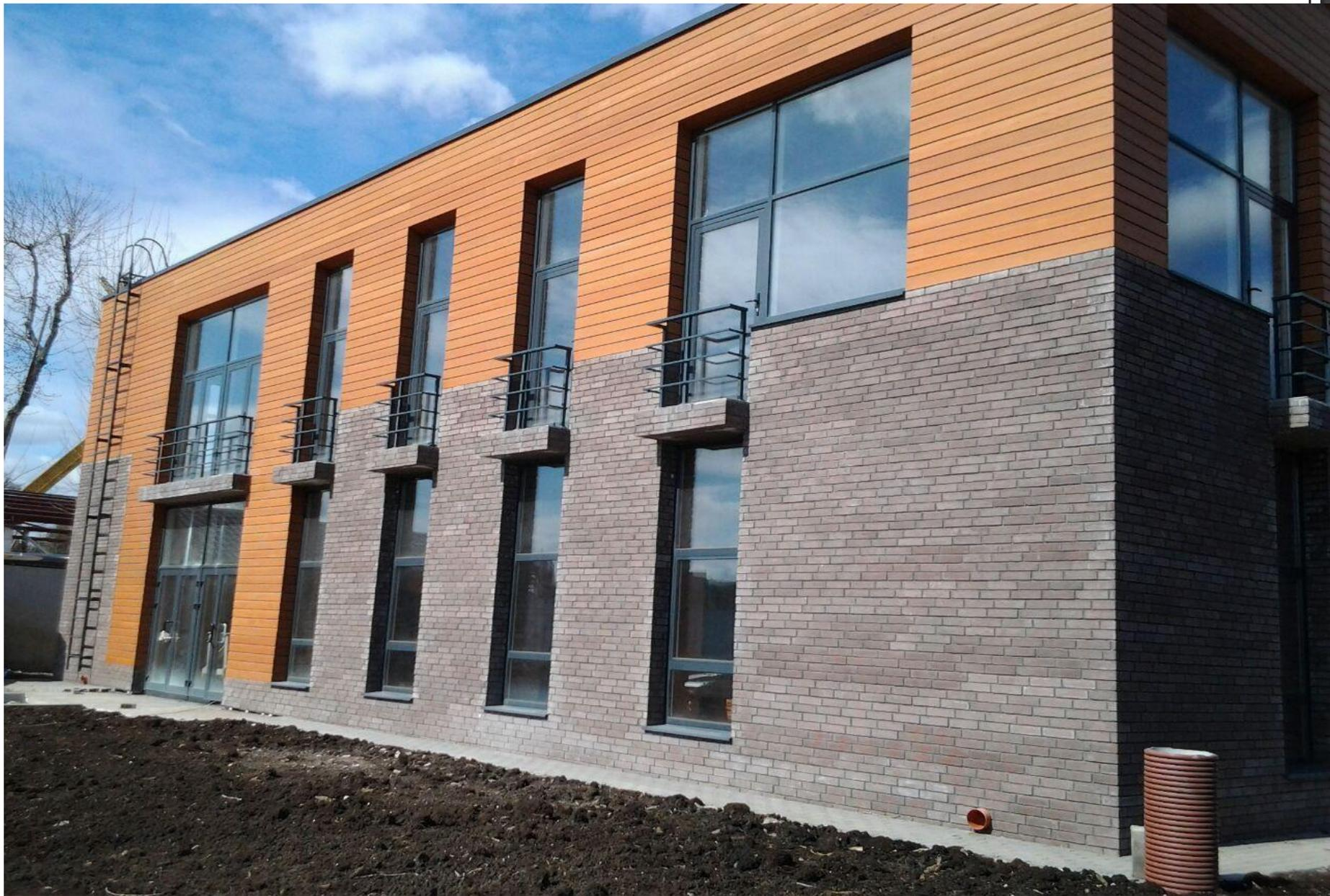
*Рис.2. Вентилируемый фасад из клинкерной плитки*
