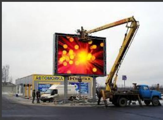
г. Санкт-Петербург, Таллинское шоссе, д. 159, ноябрь 2007 г.
