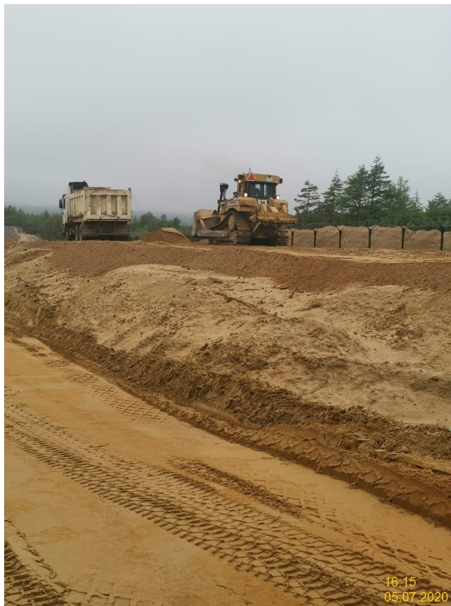
Устройство насыпи из местного песчаного грунта
