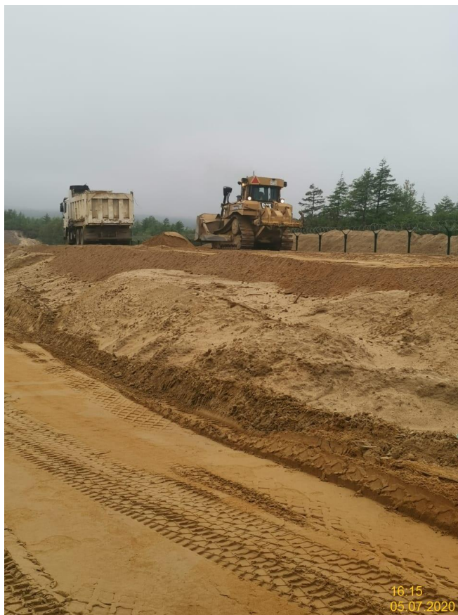
Устройство насыпи из местного песчаного грунта
