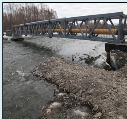
Переходы газопроводов через естественные и искусственные препятствия, в том числе через реки, железные и автомобильные дороги
