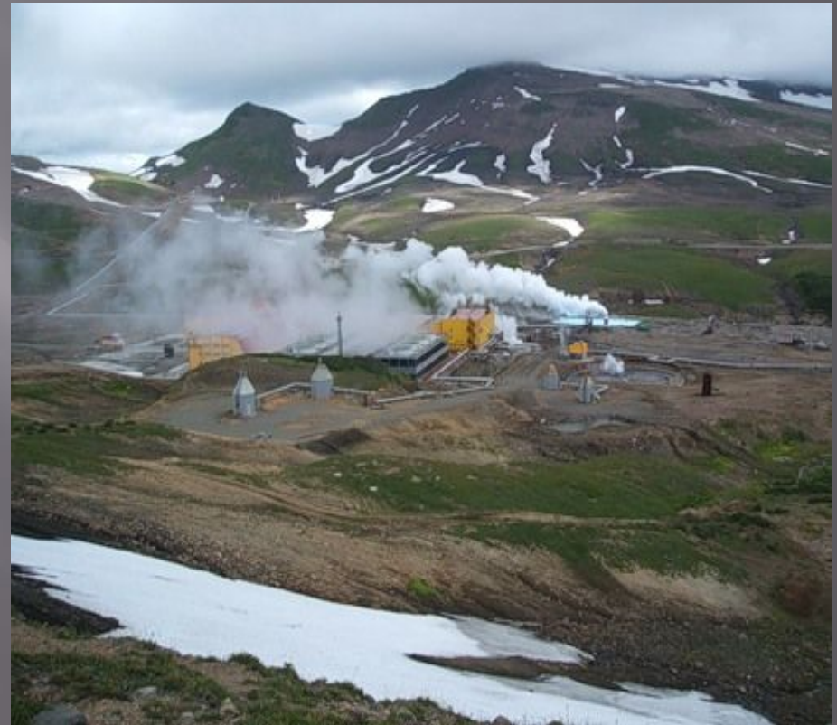
Мутновская геотермальная станция
