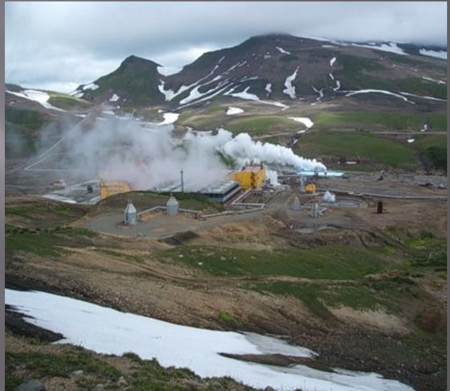
Мутновская геотермальная станция
