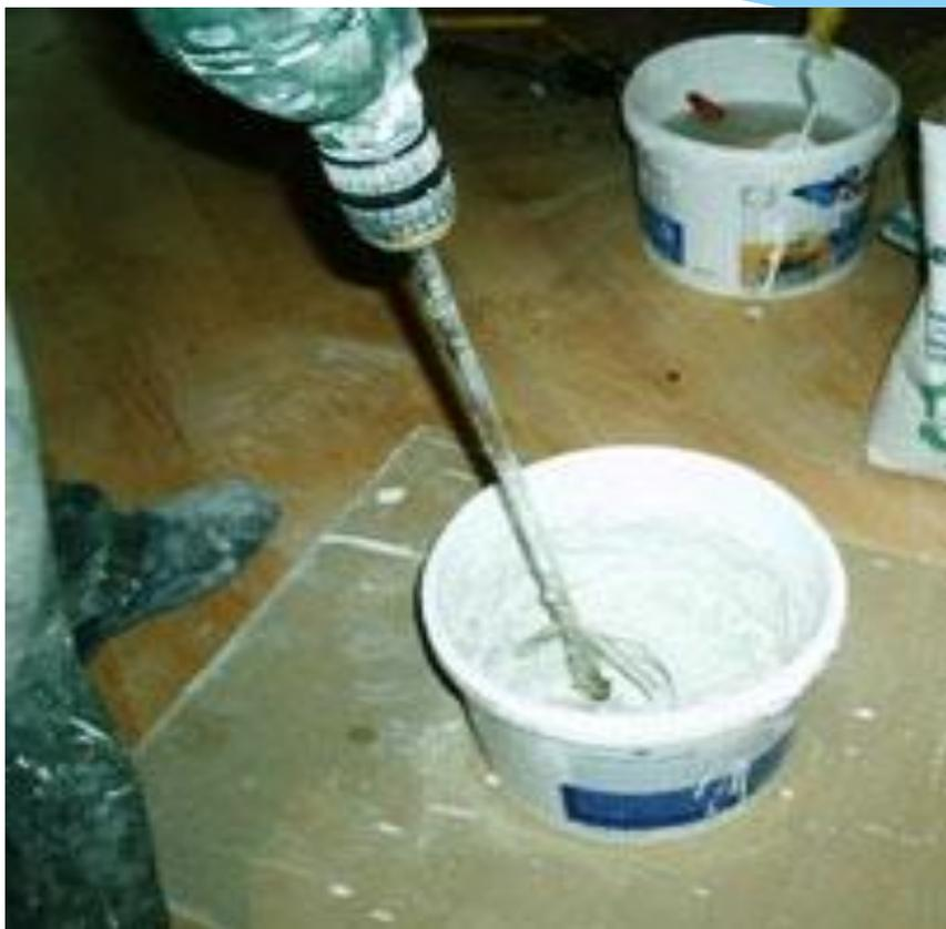
Для размешивания сухой смеси штукатурки с водой, нужен миксер или дрель с малыми оборотами с миксерной насадкой. Лучшая насадка с тремя витками.
