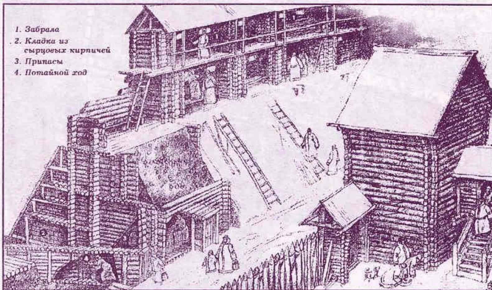
*Реконструкция оборонительного вала и крепостной стены в разрезе. Справа внизу реконструкция укреплений городского посада.*
