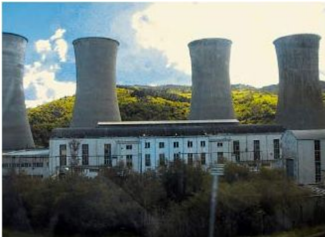
Геотермальная станция в Лардерелло
