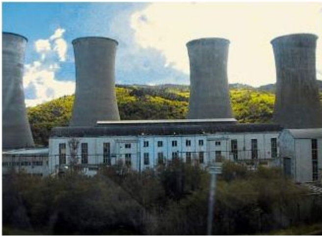
Геотермальная станция в Лардерелло
