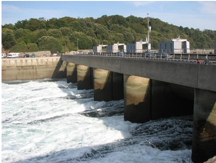
Приливная электростанция Ля Ранс
