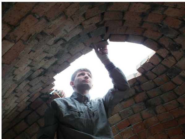
Кулиев В., архитектор, сотрудник лаборатории архитектоники и прототипирования НГУАДИ
