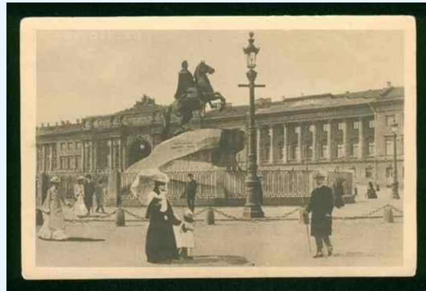
Здание Сената и Синода
