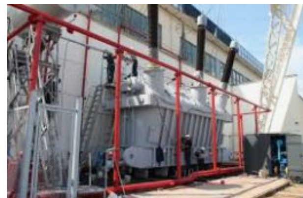
Три однофазных трансформатора возле блока АЭС
