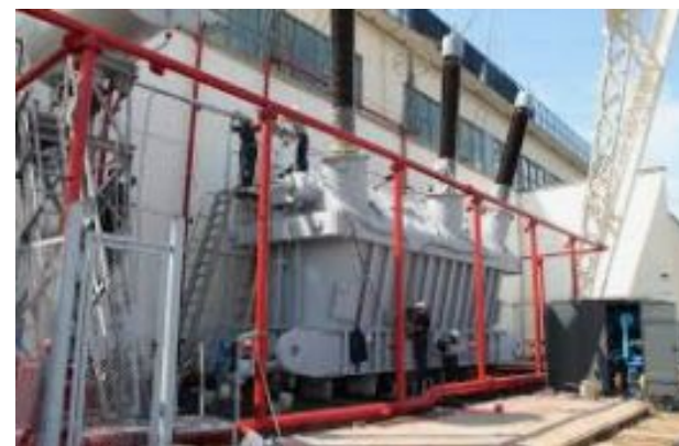
Три однофазных трансформатора возле блока АЭС
