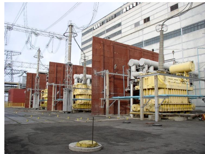
Три однофазных трансформатора возле блока АЭС
