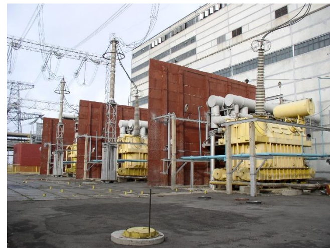
Три однофазных трансформатора возле блока АЭС
