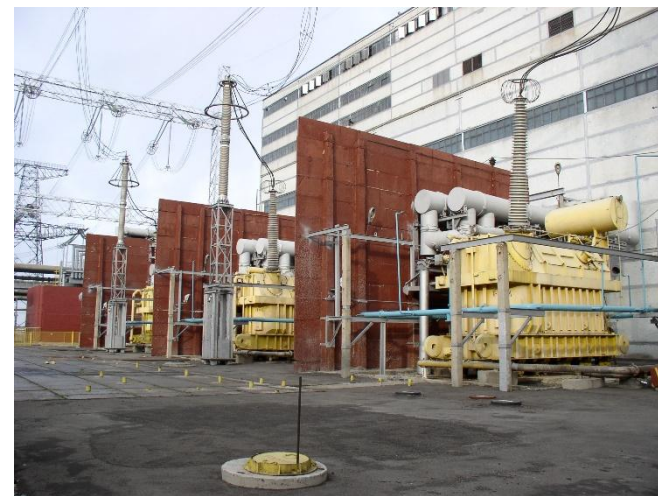
Три однофазных трансформатора возле блока АЭС
