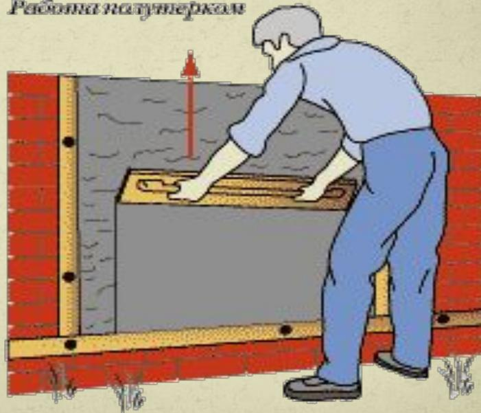
Грунт разравнивают сглаживанием или срезыванием. Заполнив пространство между маяками, следует разровнять раствор полутерком. Следите за тем, чтобы в растворе не оставалось пузырьков воздуха и покрытие плотно прилегало к стене. Движения полутерка могут быть зигзагообразные: короткие — слева направо и справа налево, длинное — вверх и немного в сторону.
