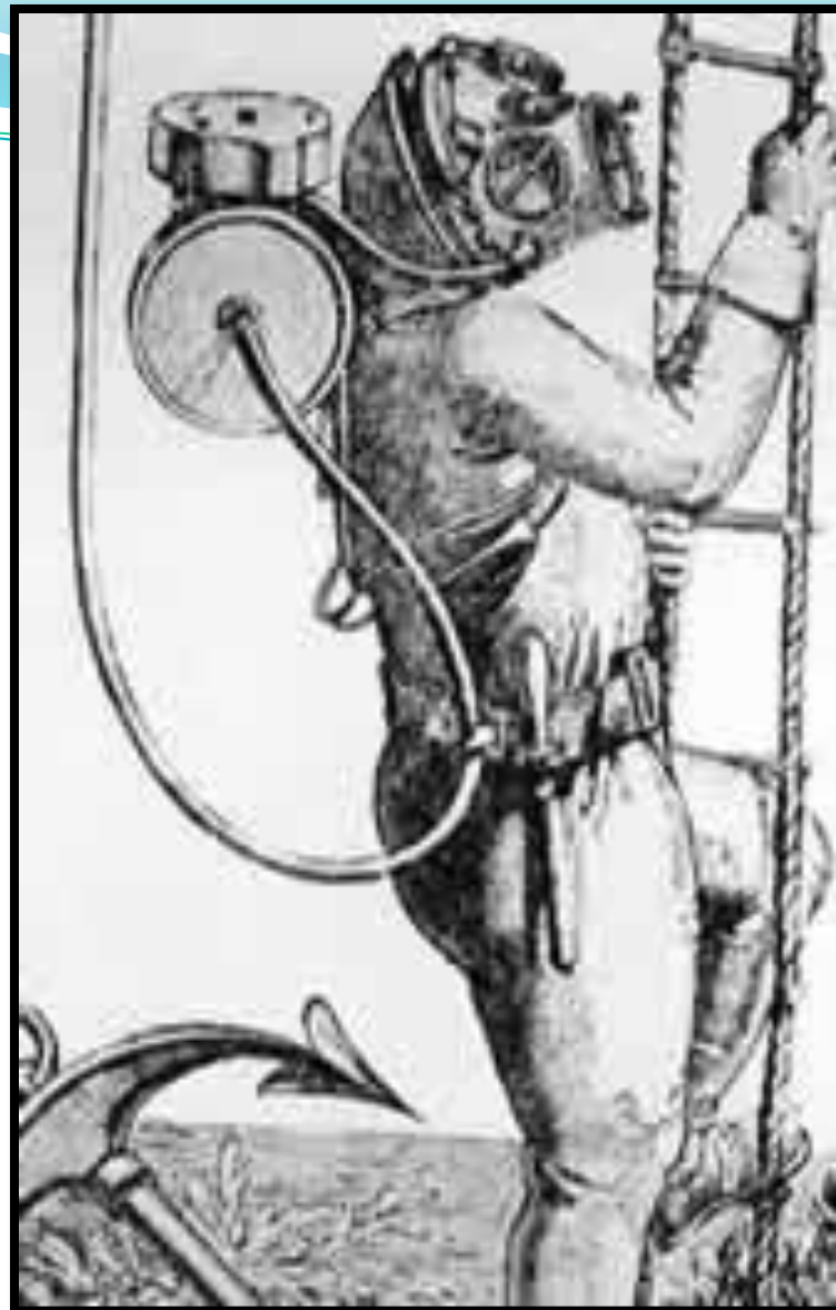
Дыхательный аппарат Бенуи Рукейроля и Огюста Денейруза 1865 – 1866 года
