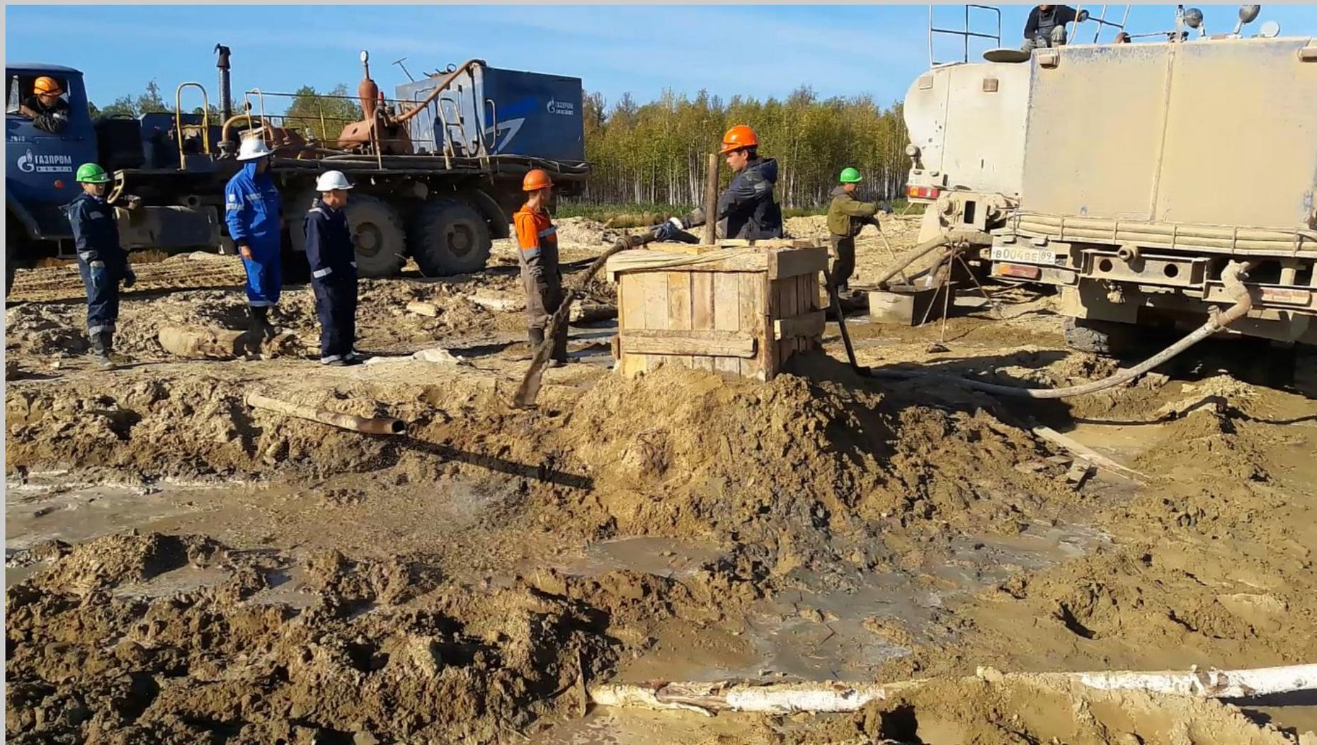
*По итогам проведения ликвидации скважины использовался цементный раствор объемом 3,97м<sup>3</sup>, закачивая в четыре приема понадобилось 3,5т сухого цемента и 2,1м<sup>3</sup> воды. Время на проведения работ ушло 213 часов.*
