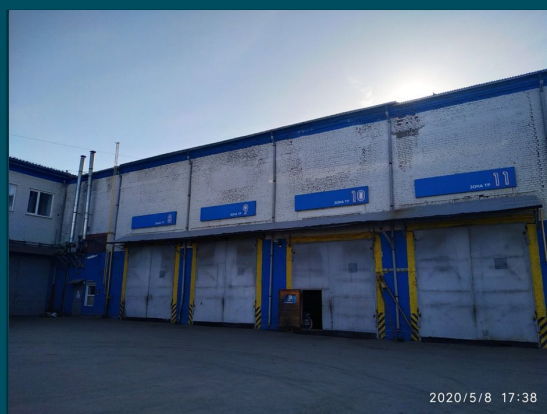
Зона текущего ремонта
