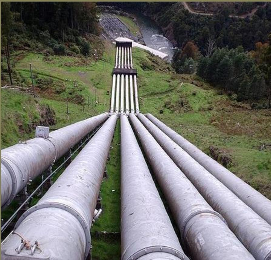
Стальные напорные трубопроводы – при напорах от 20-30 до 1800-2000 м
