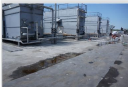
Выход на кровлю монтажников оборудования после монтажа кровли.
