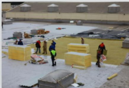
Хождение по кровле на всех этапах монтажа.
