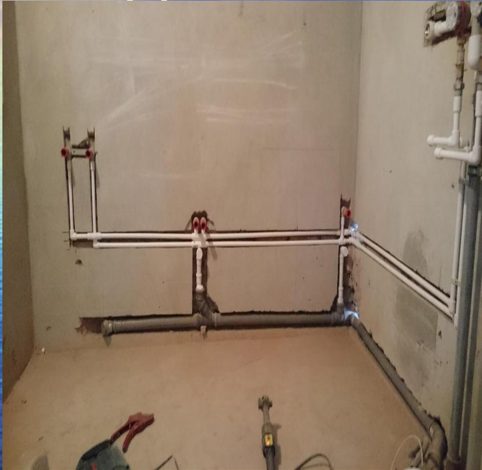
Стандартная разводка водопроводных и канализационных труб, без демонтажа со штроблением:
