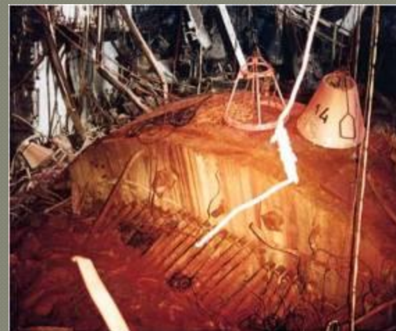
Крышка реактора после взрыва
