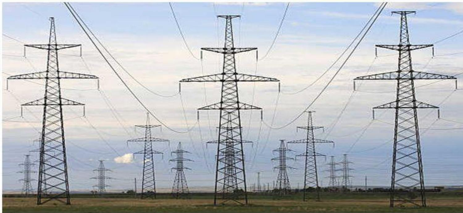
Передача электроэнергии осуществляется по проводам. Потери энергии на нагревание проводов должны быть сведены к минимуму. Для этого нужно высокое напряжение линии электропередачи. Поэтому электроэнергию и передают по высоковольтным линиям.
