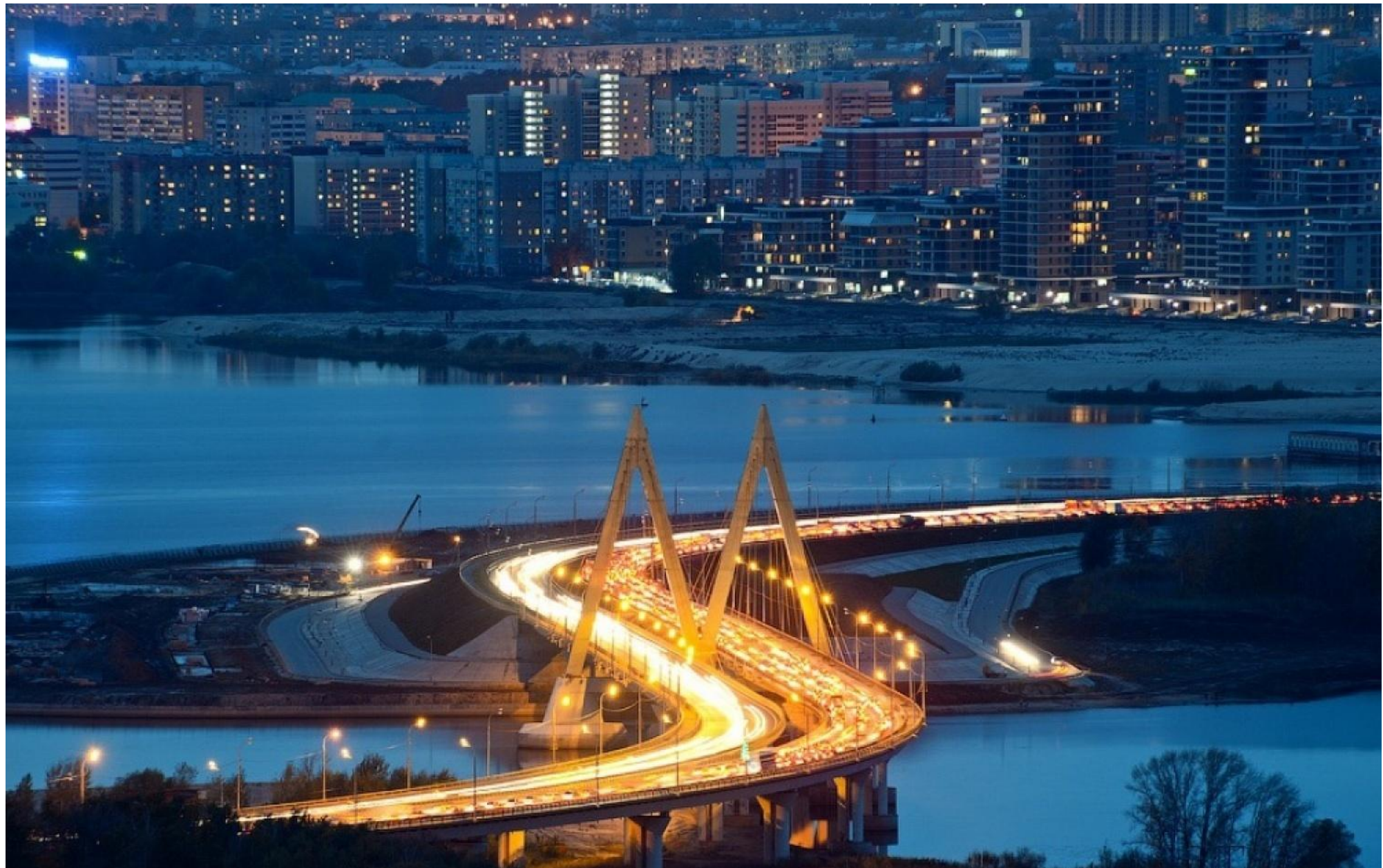
The Millennium Bridge (Kazan)
