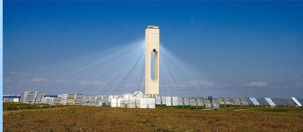
1. В основе БСЭС лежит широко известный термодинамический цикл обычной ТЭС, где вместо парового котла, нагреваемого за счет сжигания органического топлива (газ, нефть, уголь, торф и т.д.) используется аналогичный котел с разными жидкими или парообразными теплоносителями, нагреваемыми за счет СИ.
