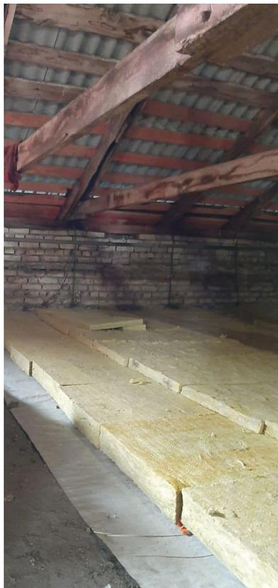
5.3.13 При укладке теплоизоляционных плит необходимо соблюдать смещение швов соседних рядов на расстояние не менее 150 мм. При укладке теплоизоляционных плит в два слоя и более смещение стыков каждого последующего слоя относительно предыдущего должно составлять не менее 200 мм.
