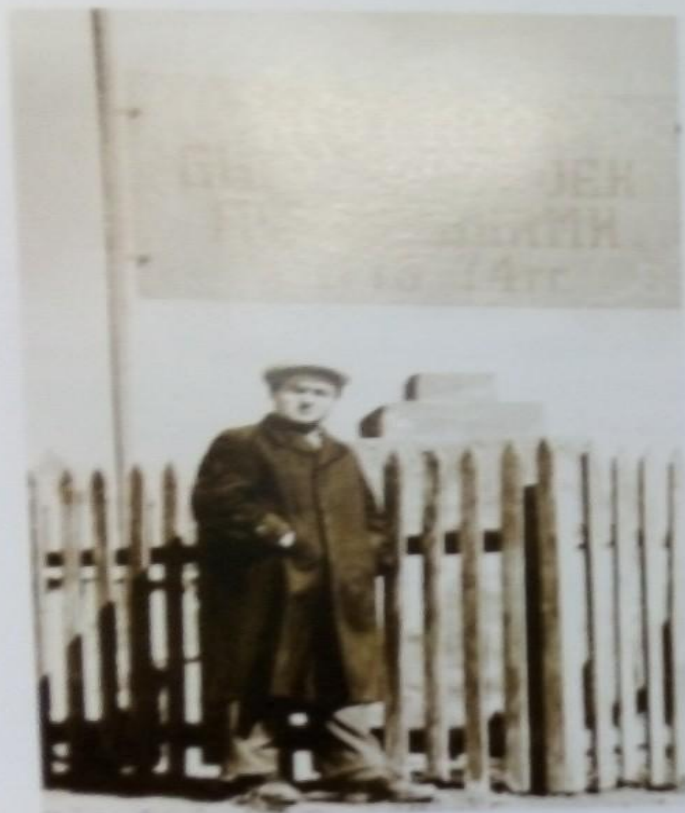
Пугачевский мост (на снимке фотокорреспондент Н.Г. Иванов)
