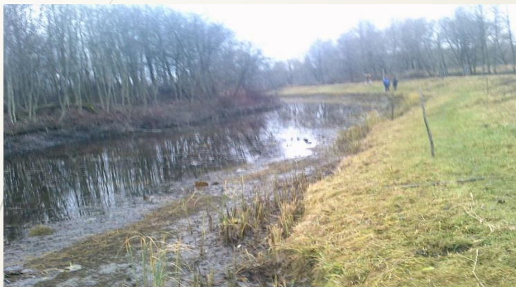
До проведения работ
