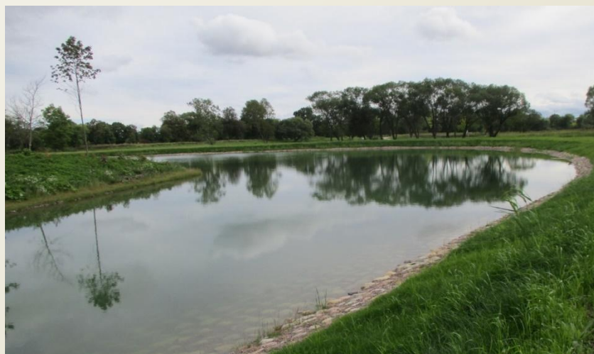
После завершения работ
