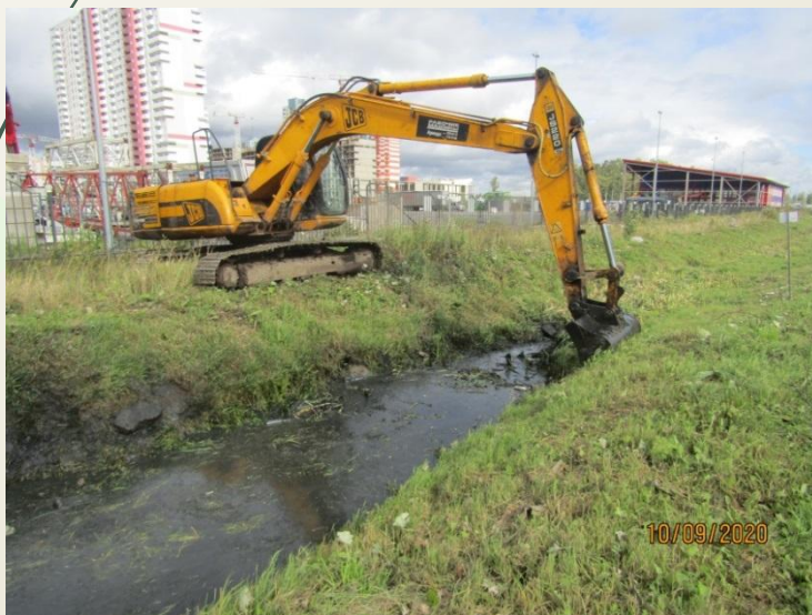
Расчистка от иловых наносов канала ОГР-13 в посёлке Шушары
