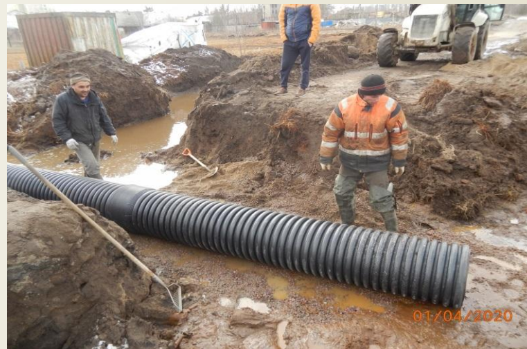
Устранение аварийной ситуации путем замены водопропускной трубы на канале МК-42 в Коломягах
