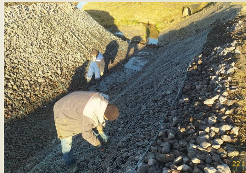
Текущий ремонт магистрального канала МК-5, принимающего сток с территории аэропорта «Пулково»
