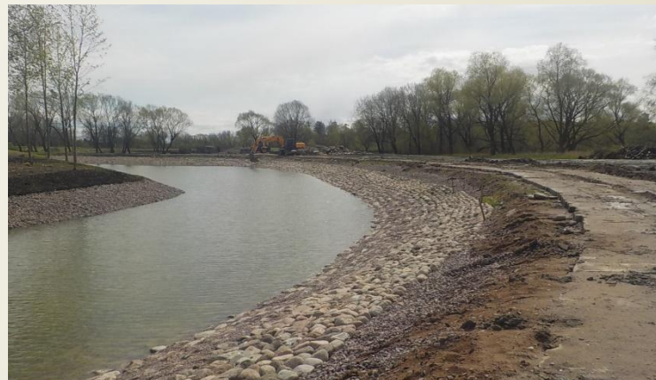
Во время проведения работ
