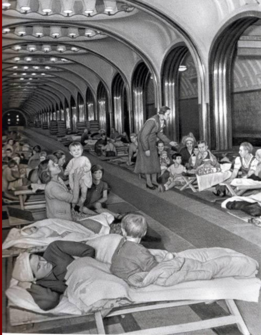
Станция метро «Маяковская» во время воздушной тревоги
