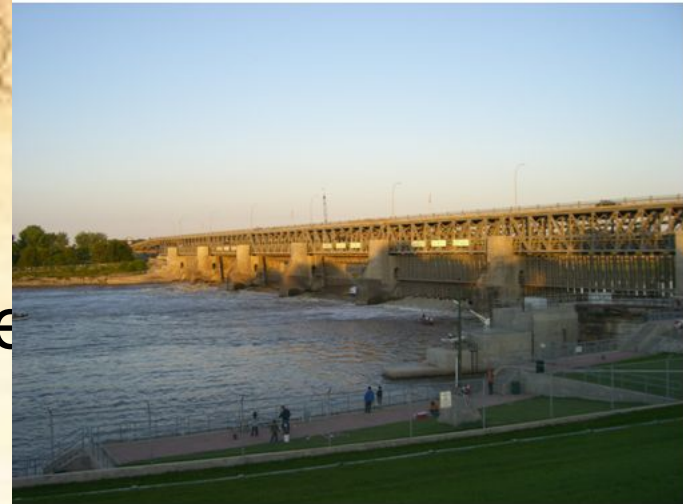
ГЭС на р. Виннипег
