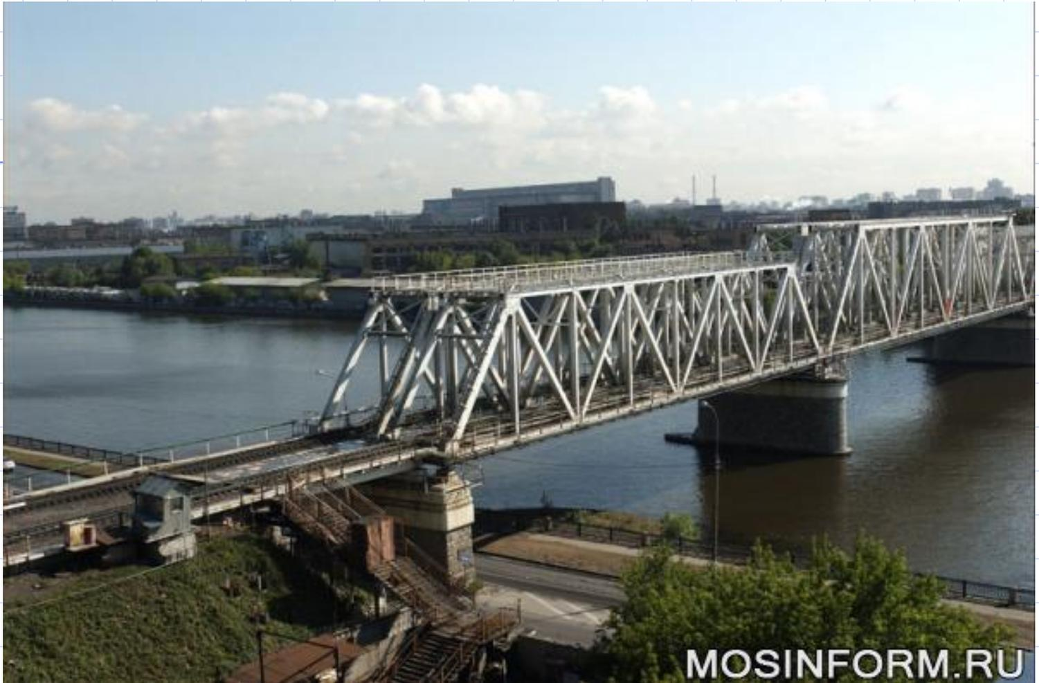
Треугольники в конструкции мостов.
